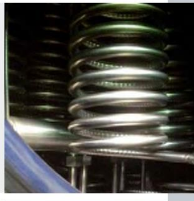
Figura6.29-Serpentines interacumulador de ACS
