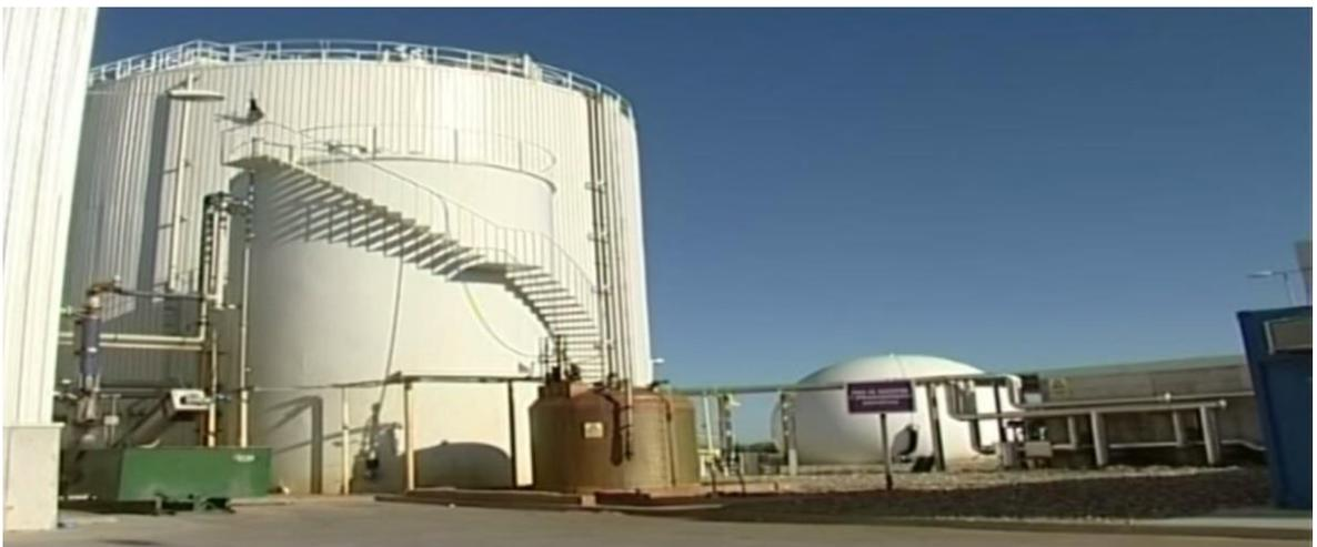
Figura 6.11.– Tanques de producción de biogás del CTR de Palencia
