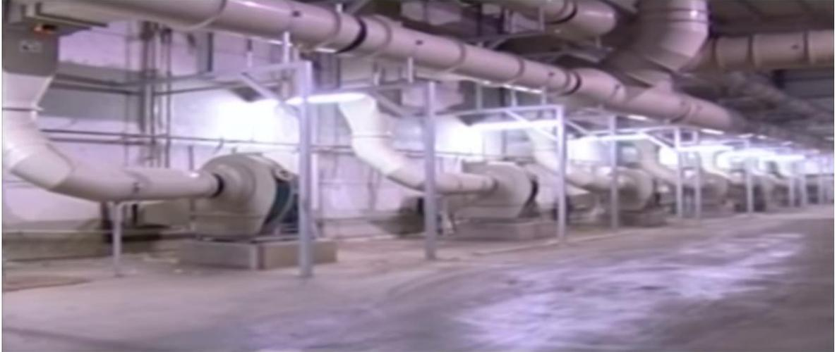
Figura 6.10.– Filtros de aire en el proceso de compostaje
