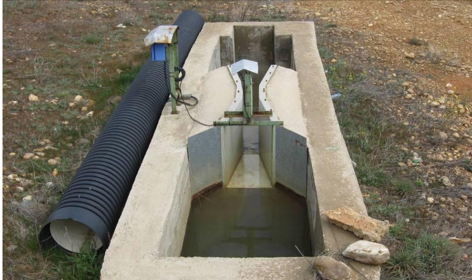
Figura5.5.6.5.1.-Medidor tipo Parshall.
