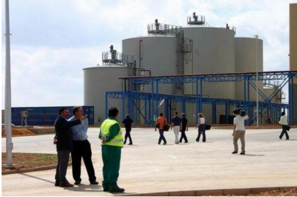
Figura 5.5.1.2.1.1.-Tanques de hidrólisis y biometanización.
