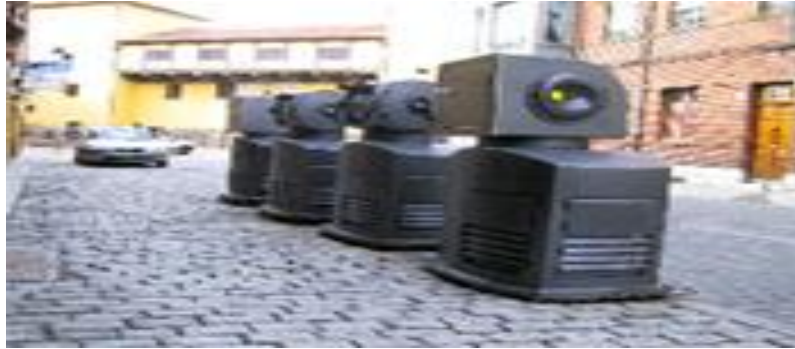
Figura 2.3.- Buzones del sistema neumático en el barrio húmedo (León).
