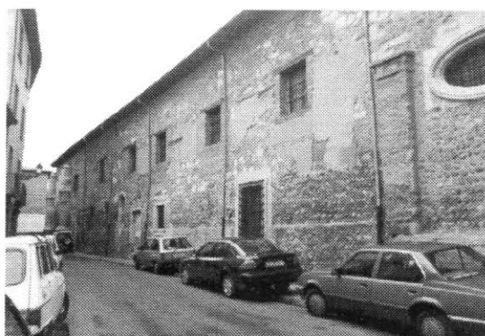
Figura 7. Situación actual del exterior de la panda oeste del claustro.
