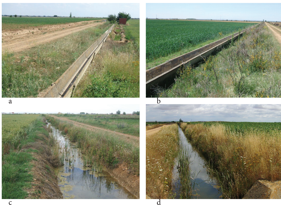
Figura 4. Aspecto de los canales de riego tradicional; a y b) canales de hormigón, c y d) canales naturalizados.
