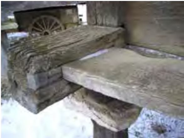
FIG. 08.114 Encaje en el lateral del trabe. Prioro_07 (L01).
