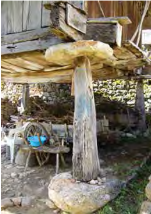
FIG. 13.02 Sistema de sustentación. Corés_11 (A08_04).
