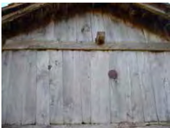
FIG. 08.063 Cabeza de tirante ensamblada con el liño. Oseja de Sajambre_15 (L04).
