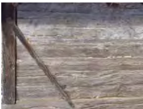
FIG. 12.35 Pared de la caja por apilado, sistema con bastidor. Felechas_04 (L02).
