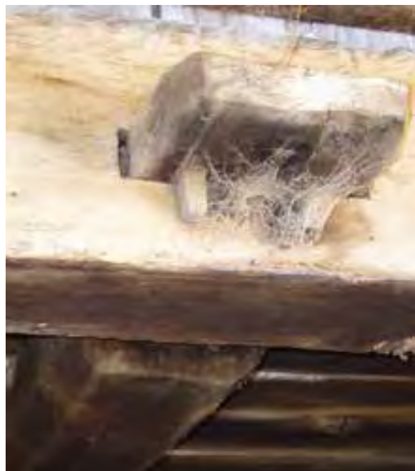
FIG. 13.27 Ensamble trabe-sobigaño. Oseja de Sajambre_14 (L04).
