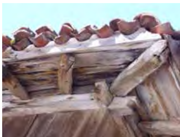
FIG. 08.078 Aguilones con faldones de cabios. Torrestío_08 (L06).
