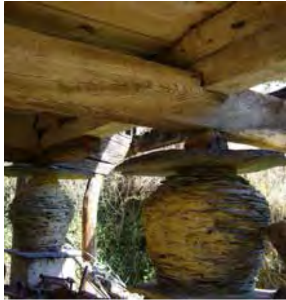
FIG. 13.05 Pegollos de mampostería. Fondodevilla_04 (A11_02).
