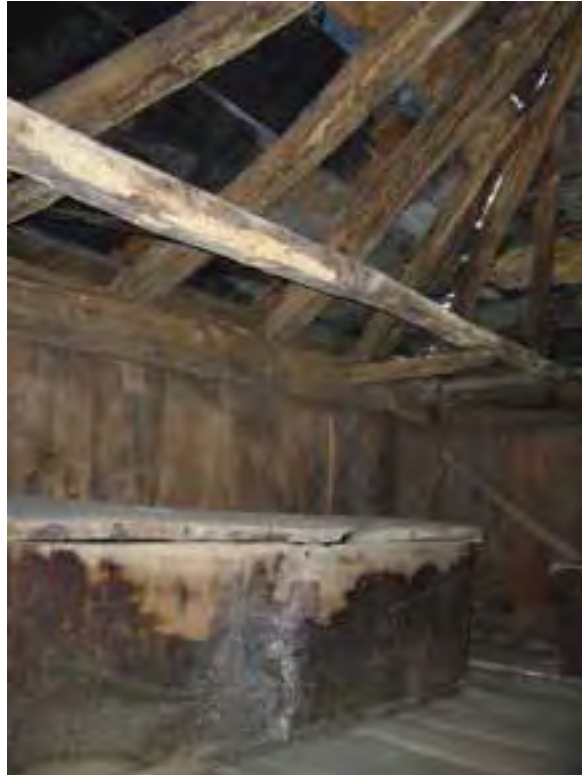
FIG. 08.064 Tirantes dobles en dos direcciones (Z4). Degaña_08 (A10).
