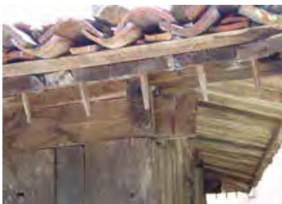
FIG. 08.095 Listón superior, cosiendo tablones y formando la bocateja. Ronderos_04 (A06_02).
