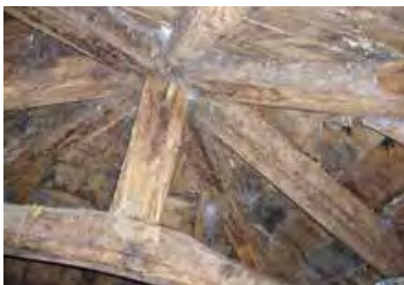
FIG. 13.35 Curvatón en un ejemplar con cubierta en pabellón. Santa Marina_12 (L03).
