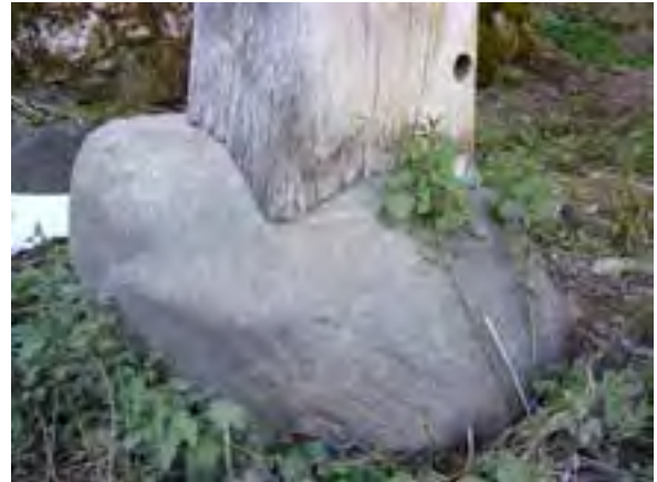
FIG. 13.03 Pegollo adaptada a la basa. Soto de Valdeón_08 (L03).
