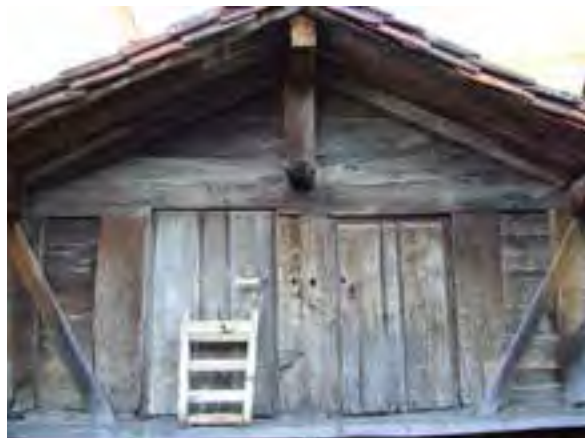
FIG. 08.075 Pical de tabla horizontal y con pinacho enano. Caldevilla_05 (L03).
