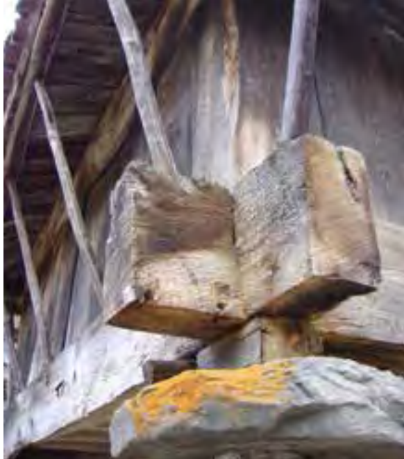
FIG. 08.025 Traveses enrasados con ensamble completo. Belerda_02 (A03_01).
