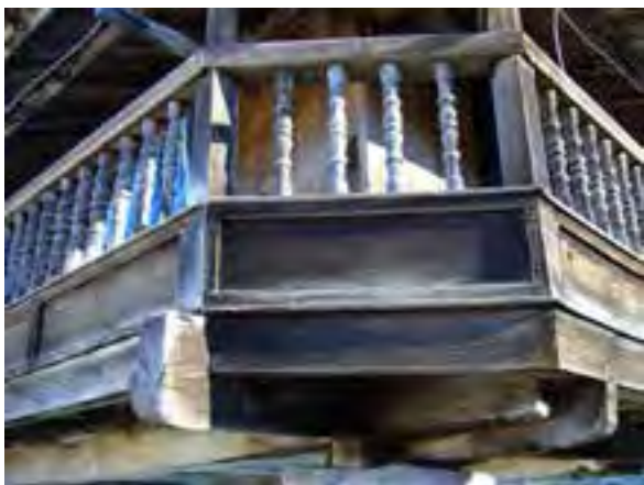
FIG. 08.126 Antepecho de barrotillos torneados. Corés_08 (A08_04).
