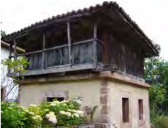
FIG. 08.023 Plinto cuyo techo es el suelo de la caja. Barrio_07 (A07_02).
