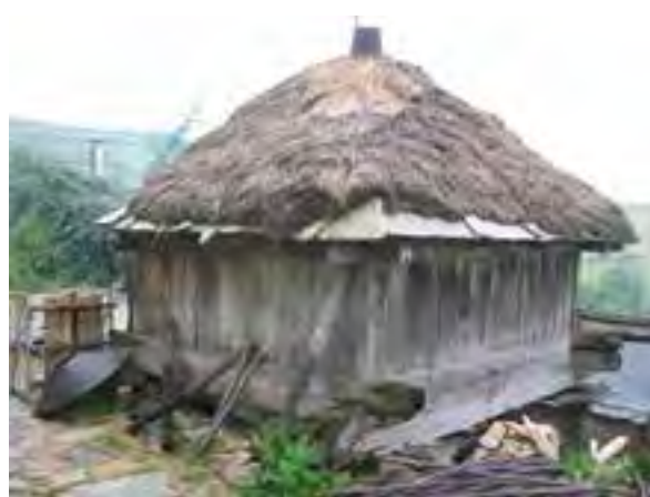
FIG. 08.106 Paja encintada con losa. Cantejeira_02 (L11).
