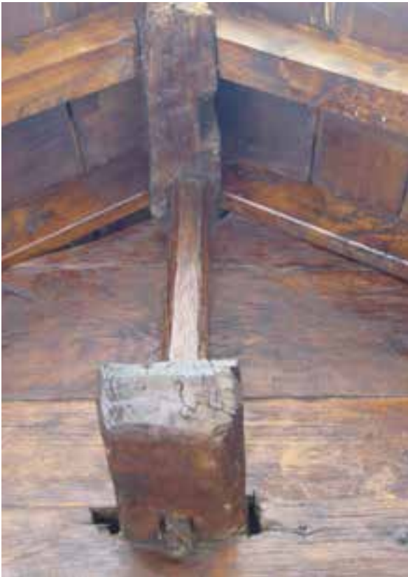
FIG. 08.045 Pinacho enano en un hastial. Boca de Huérgano_02 (L02).
