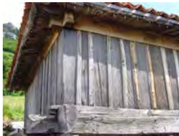
FIG. 08.050 Listones tapando juntas entre colondras. Cortes_06 (A06_01).
