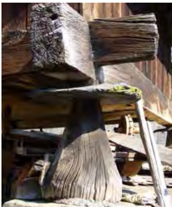
FIG. 08.027 Traveses desiguales, con canto diferente. Buso_04 (A11_02).
