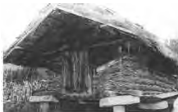
FIG. 04.09 Hórreo de caja textil y planta rectangular. M. Caamaño, Galicia, las construcciones de la Arquitectura Popular... , p. 310.
