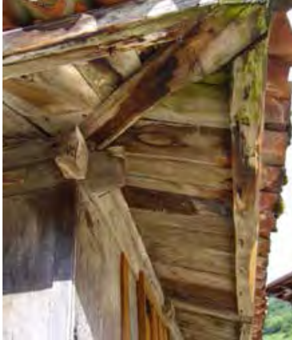
FIG. 08.094 Sopanda apoyada en aguilones y cabio central. Cortes_05 (A06_01).
