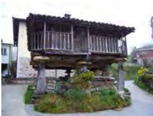
FIG. 09.10 Amieva_04 (A02_02). Hórreo con más de 4 apoyos.
