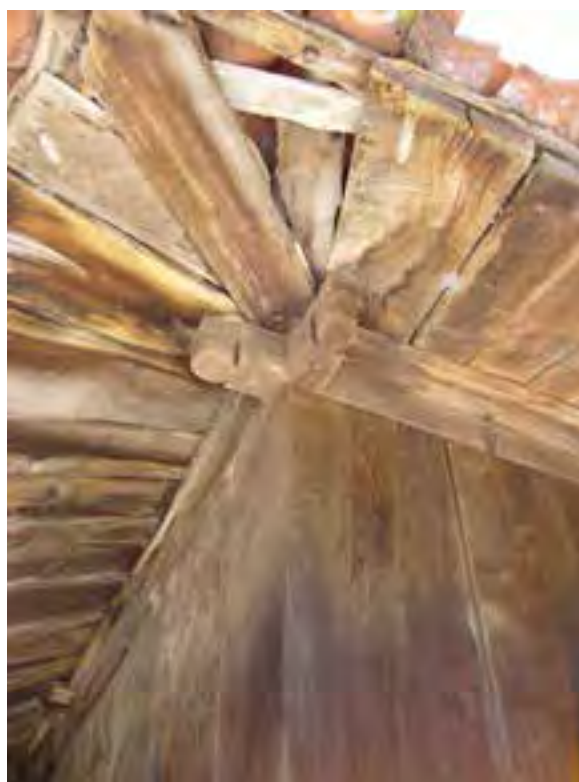
FIG. 13.58 Pieza desprendida en el vértice del faldón. Ricabo_01 (A06_02).
