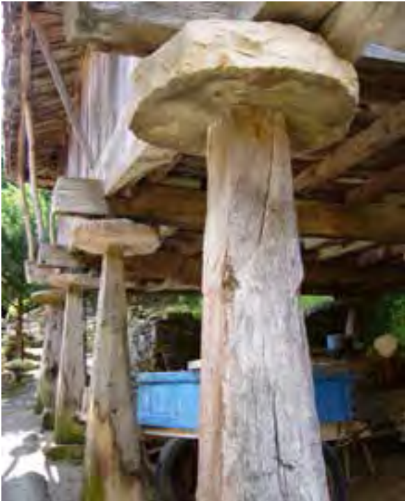
FIG. 08.006 Pegollo troncopiramidal de madera. Barrio_05 (A07_02).
