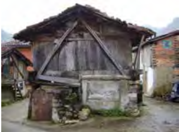
FIG. 13.52 Arriostramiento excepcional de un hórreo sin bastidor a dos aguas (endemismo local). Bezanes_07 (A03_01).
