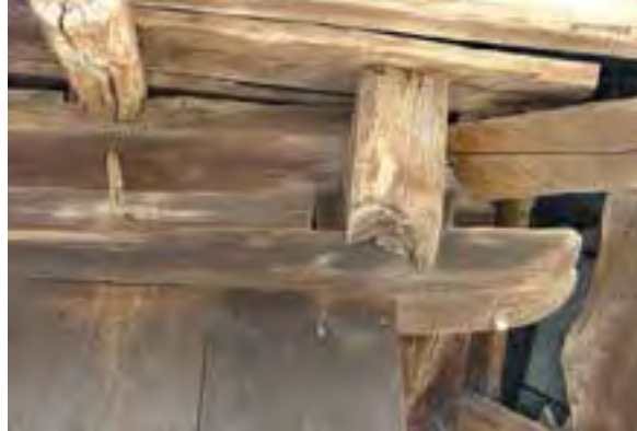
FIG. 08.059 Durmiente recto (detalle). Rabanal de Arriba_03 (L07).
