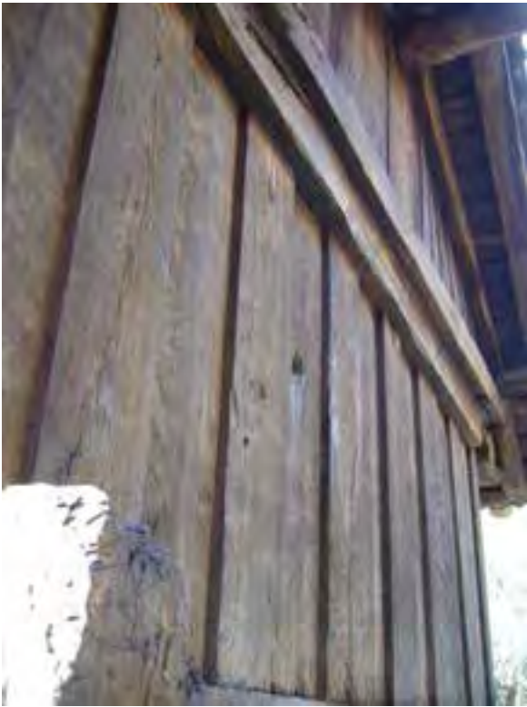
FIG. 08.051 Colondras alternadas. Baró_01 (C01).
