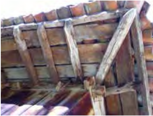
FIG. 08.082 Cabios en perpendicular al alero. Aguino_05 (A08_03).
