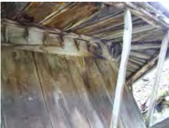
FIG. 08.057 Priegos clavados a un liño. Viego_04 (A02_03).
