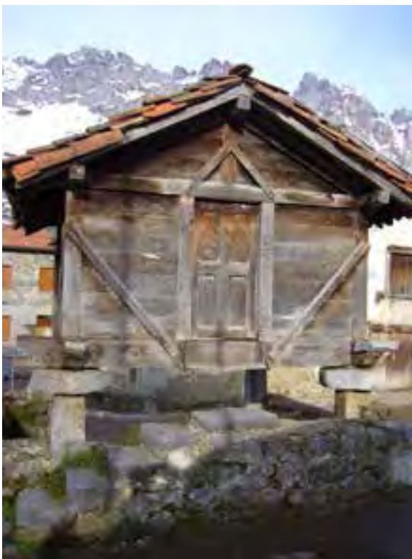
FIG. 09.16 Posada de Valdeón_06 (L03). Hórreo con bastidor y cubierta a dos aguas.
