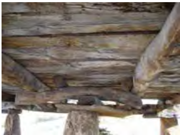
FIG. 08.036 Pegollo central y ménsula para dos vigas. Felechas_03 (L02).
