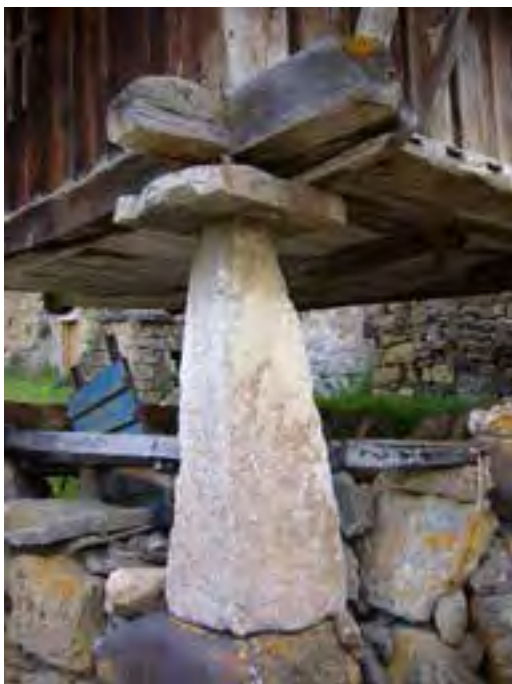
FIG. 08.008 Sillar troncopiramidal. Perlunes_03 (A08_03).
