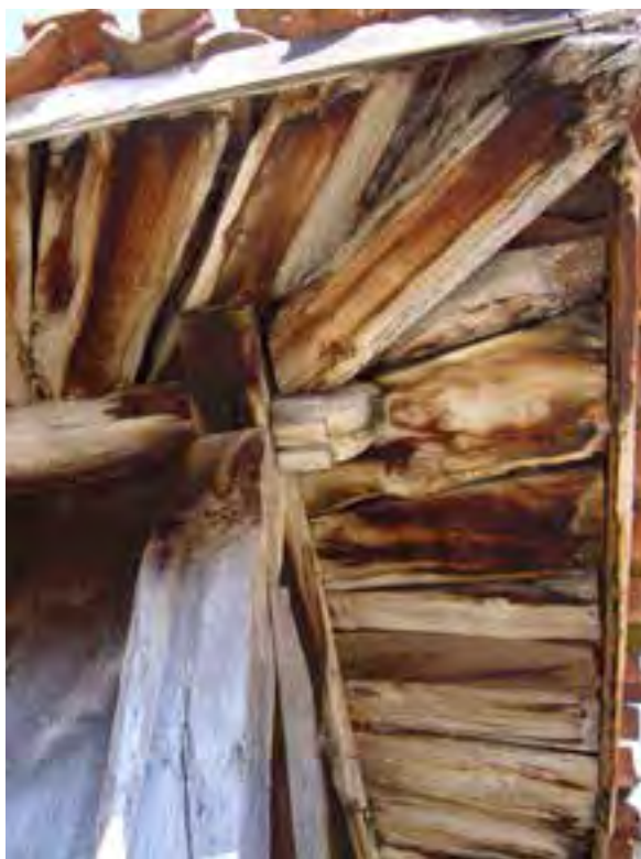
FIG. 08.079 Aguilones con faldones de tabloncillos. Caldevilla_08 (I03)
