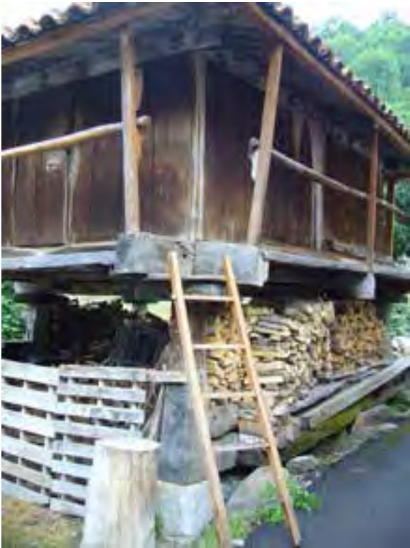
FIG. 08.109 Escalera de mano. Soto de Sajambre_01 (L04).
