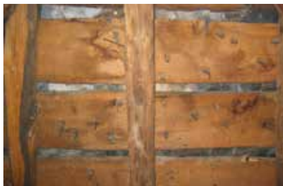
FIG. 08.101 Clavos de madera. Cuevas_01 (L08).
