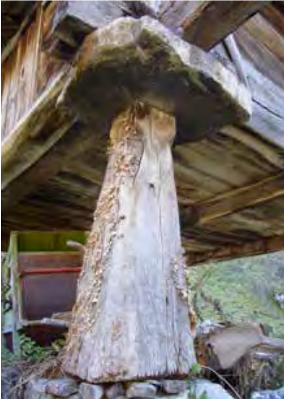
FIG. 13.04 Pegollo troncopiramidal de madera. Cordiñanes_05 (L03).
