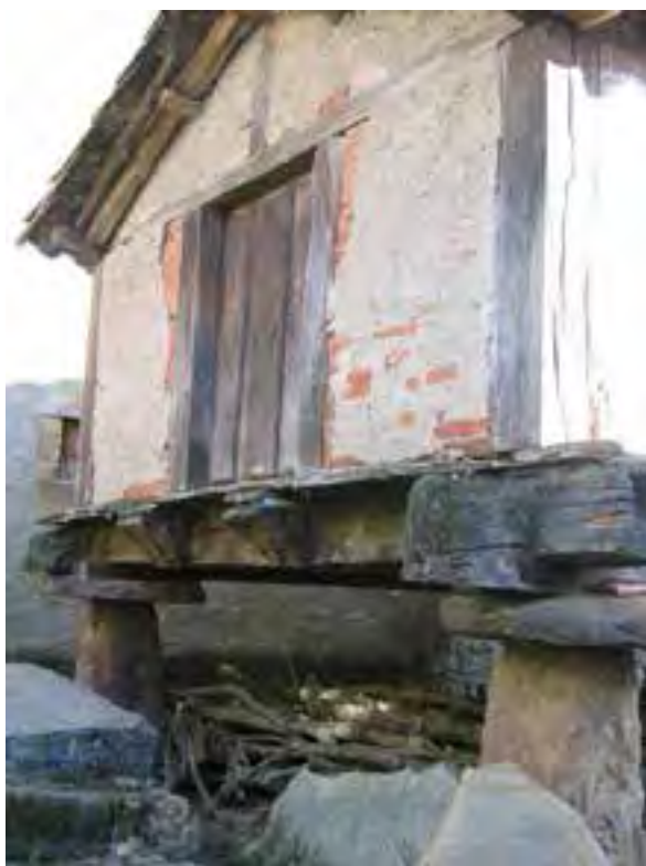
FIG. 06.23 Créménes_02 (L02). Ejemplar con entrepaños de ladrillo.
