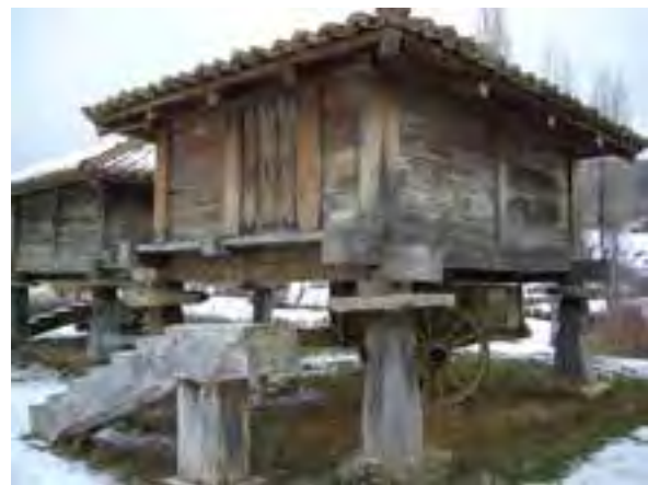
FIG. 08.070 Puerta en el lado de los traves bajos. Prioro_08 (L01).
