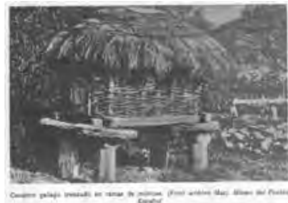
FIG. 12.16 Canastro sobre cuadro de traveses. En E. Frankowsky, Hórreos y palafitos... , p. 439.
