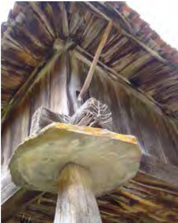
FIG. 08.015 Tornarratas desbastado circular. Navedo_01 (A05_01).
