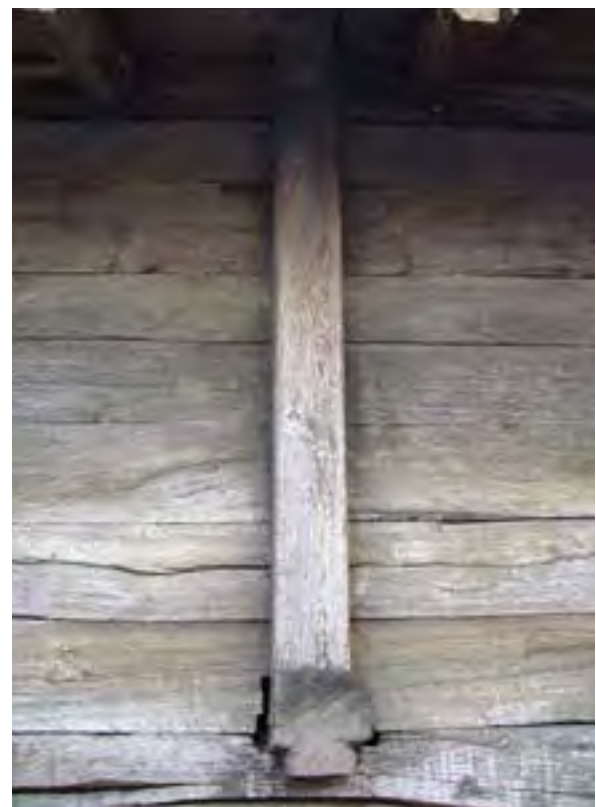
FIG. 12.10 Pared rigidizada con un pinacho. Prioro_06 (L01).
