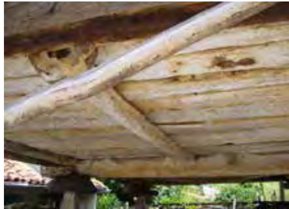
FIG. 13.25 Sobigaño colgado del trabe. Páramo_02 (A07_01).
