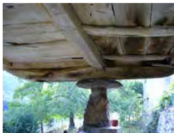
FIG. 08.123 Ménsula colgada para sustento del corredor. Degaña_01(A10).
