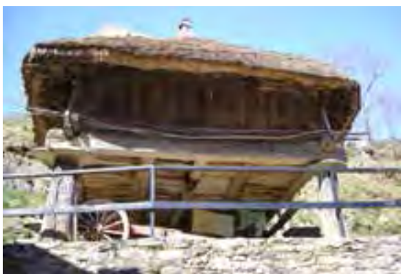
FIG. 13.29 Suelo de tres vigas. Balboa_03 (L11).
