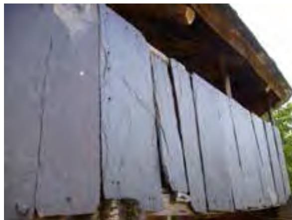
FIG. 08.127 Antepecho de lajas de pizarra. Fondodevilla_02 (A11_02).
