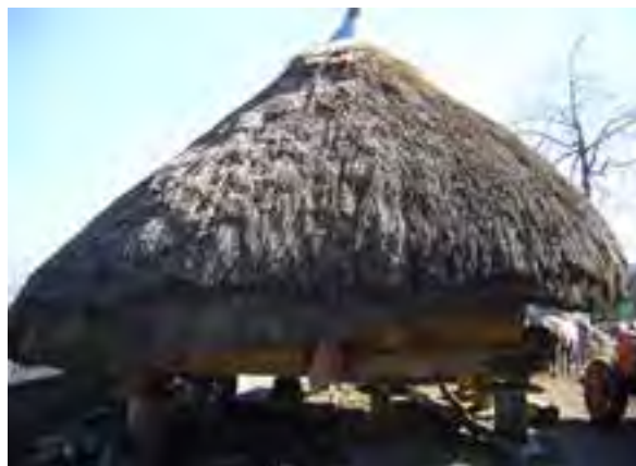
FIG. 09.23 Laguna_01 (L11). Hórreo sin bastidor y cubierta de paja.
