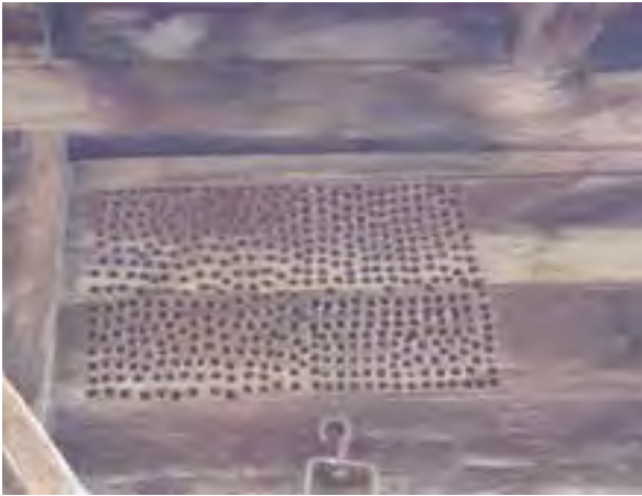
FIG. 06.39 Los Llanos_07 (L03). Perforaciones para ventilar la caja.
