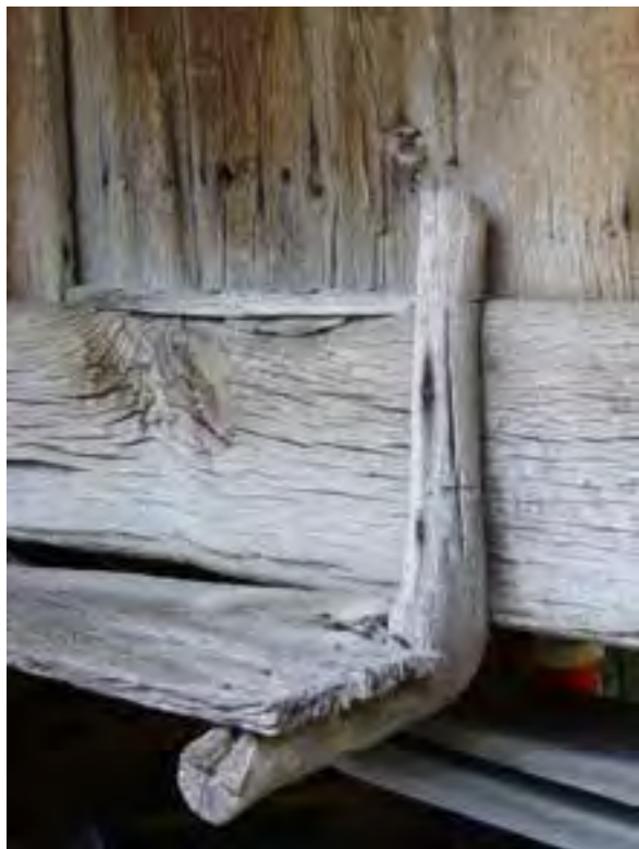
FIG. 08.115 Escuadra de madera. Degaña_02 (A10).
