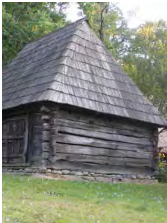
FIG. 12.08 Construcción de tablones ensamblados. Museo etnográfico Astra (Rumanía).
