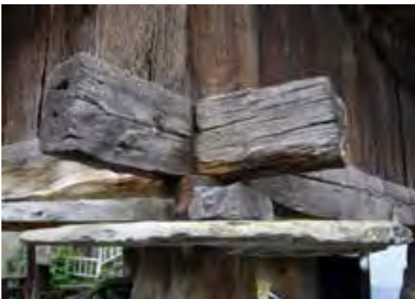
FIG. 08.016. Tornarratas laminar. Casomera_03 (A04_02).
