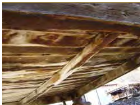
FIG. 13.24 Suelo de tabloncillos dotado de una viga central. Soto de Valdeón_04 (L03).
