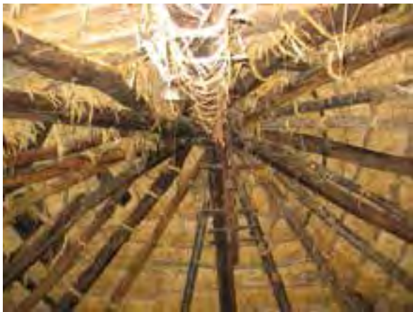
FIG. 08.086 Rollizos en disposición radial para cubierta cónica de paja. Paradela_01 (L11).
