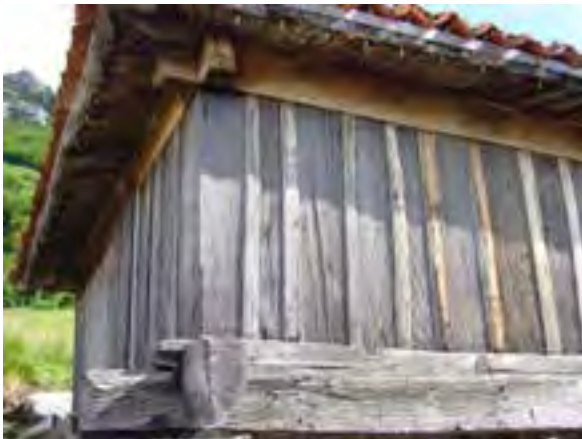
FIG. 08.098 Pinas asentando las canales de la teja. Cortes_06 (A06_01).
