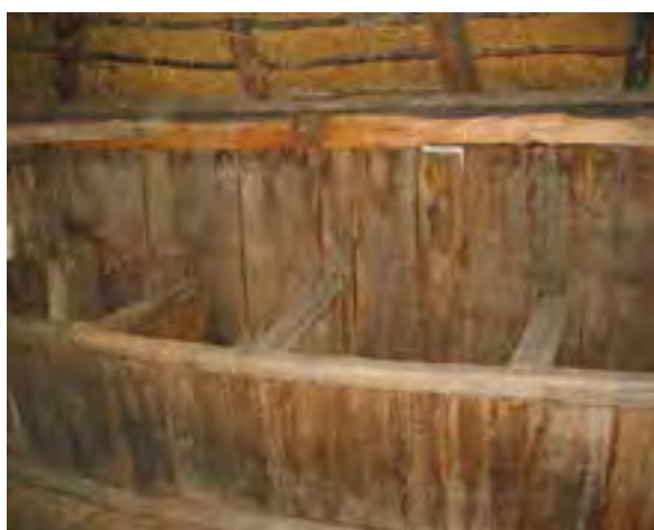
FIG. 08.131 Troje compartimentado. San Miguel_10 (L07).
