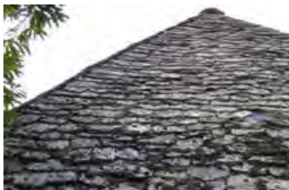
FIG. 08.100 Losa a granel. Cela_04 (G02).
