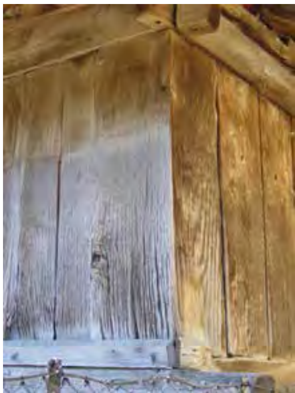
FIG. 12.32 Esquina de la caja con engüelgo. Torrestío_05 (L06).
