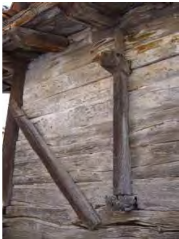
FIG. 12.22 Hórreo con cantoneras y pinachos. Felechas_04 (L02).
