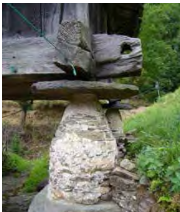
FIG. 13.12 Sistema de sustentación inmueble: murete y pegollo. Regla de Cieba_06 (A09_02).
