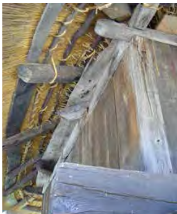
FIG. 08.061 Durmiente curvo, adaptado a cubiertas de paja. Balboa_05 (L11).
