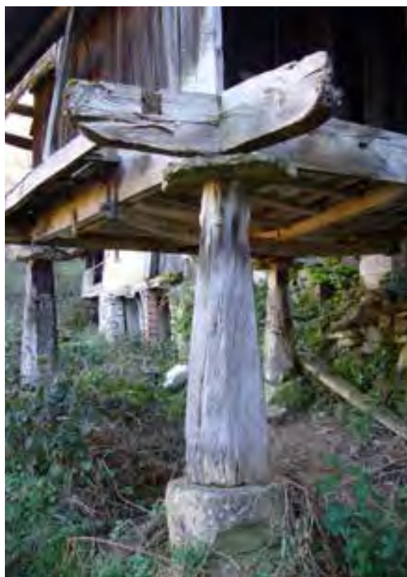
FIG. 13.01 Sistema de sustentación. Coto_02 (A08_02).
