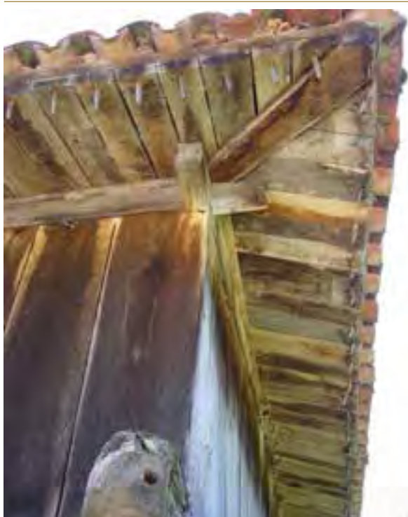
FIG. 08.096 Pinas en el borde del alero. Bueida_01 (A06_02).
