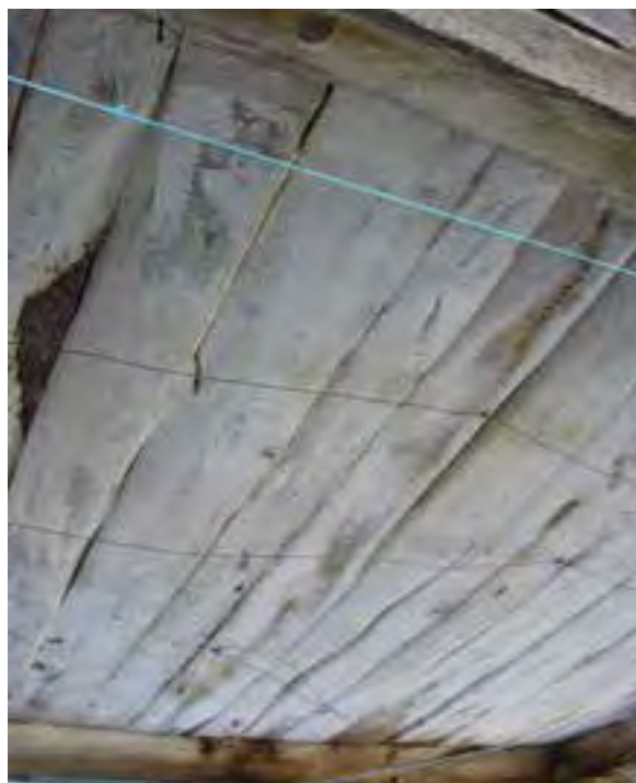
FIG. 08.030 Suelo elemental de tablones. Torrestío_05 (L06).
