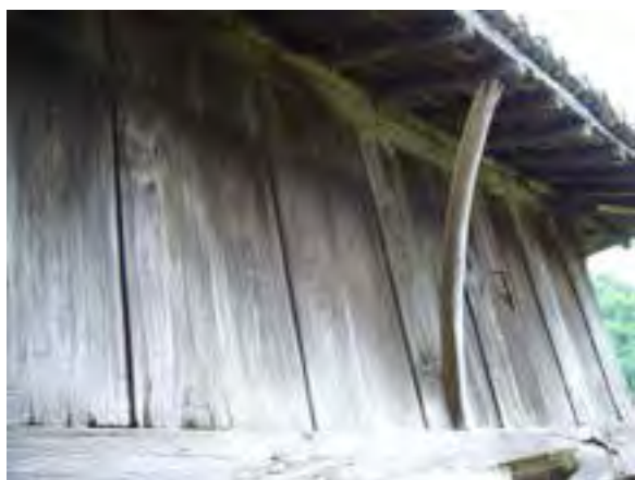
FIG. 08.091 Tentemozos curvados. La Enfistiella_08 (A04_03).
