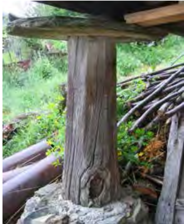
FIG. 08.007 Pegollos cilíndrico de madera. Cantejeira_02 (L11).
