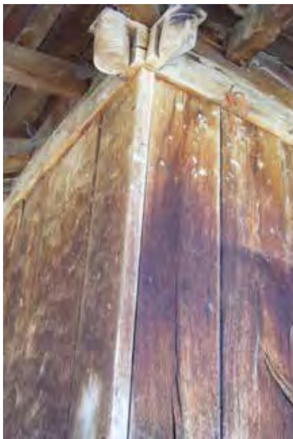
FIG. 12.33 Esquina de la caja con las colondras a tope. Urria_05 (A08_02).
