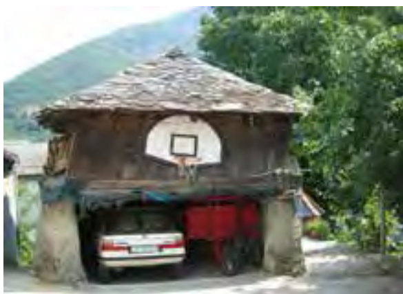
FIG. 13.39 Caja desplomada en un hórreo sin bastidor. Palacios_05 (L08).
