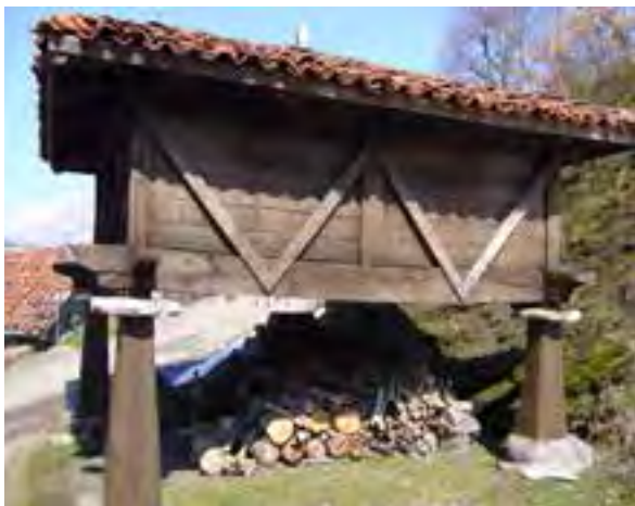
FIG. 13.37 Riostras en un hórreo con bastidor. Caldevilla_06 (L03).
