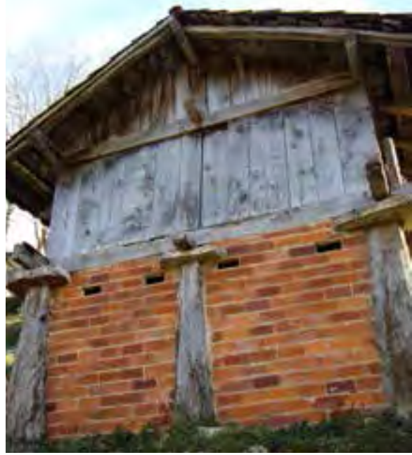
FIG. 08.024 Plinto añadido. Oseja de Sajambre_02 (L04).
