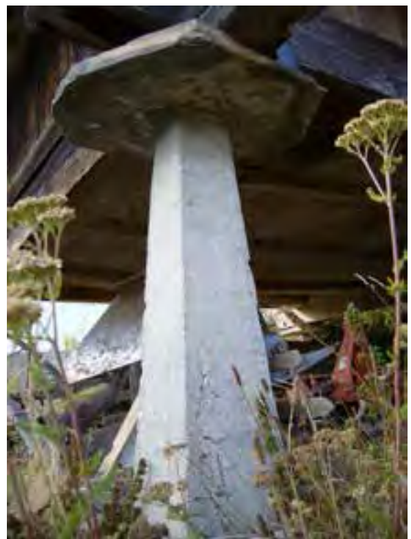
FIG. 08.013 Pegollos troncopiramidal de hormigón armado. Cela_6 (G02).
