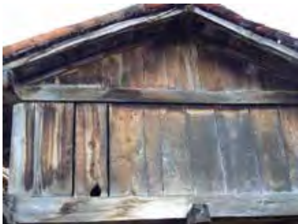
FIG. 08.074 Pical de tabla vertical. Oseja de Sajambre_06 (L04).
