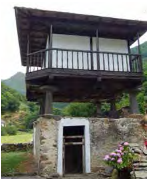
FIG. 06.21 Sorrodiles_17 (A09_02). Ejemplar con paredes de ladrillo.
