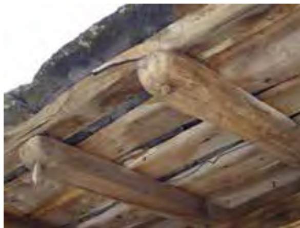
FIG. 08.081 Cabios escuadrados, y cosidos al borde del alero. Sorrodiles_22 (A09_02).
