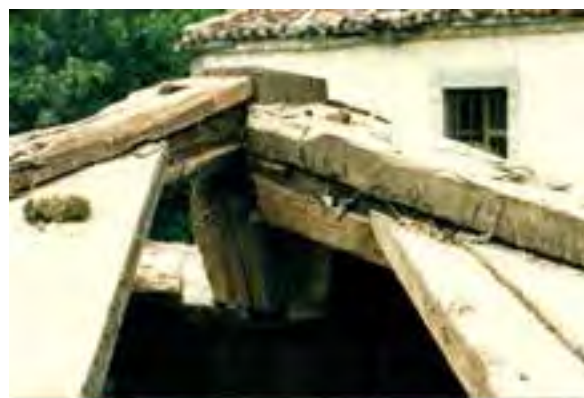
FIG. 13.60 Ranura en el aguilón para apoyar los tabloneros. Restauración de los hórreos de Valdeón (L03), 1988-1992.
