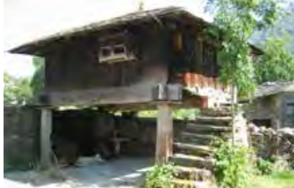
FIG. 13.10 Hórreo con pegollos de sillería excesivamente esbeltos. Caboalles de Arriba_11 (L07).
