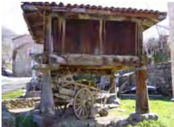
FIG. 12.36 Hórreo con bastidor, tabla vertical y cubierta a 4 aguas. Caldevilla_09 (L03).
