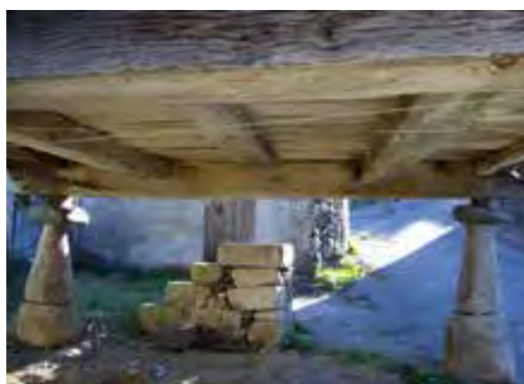
FIG. 08.031 Suelo con tres vigas. Vilarello_03 (G01).
