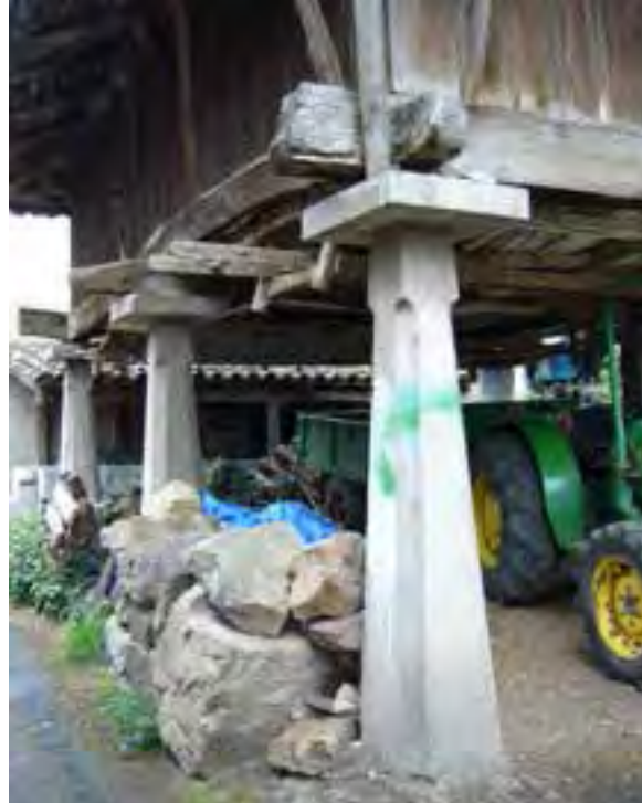
FIG. 13.14 Sistema de sustentación de hormigón armado. Villar de Vildas_05 (A08_04).
