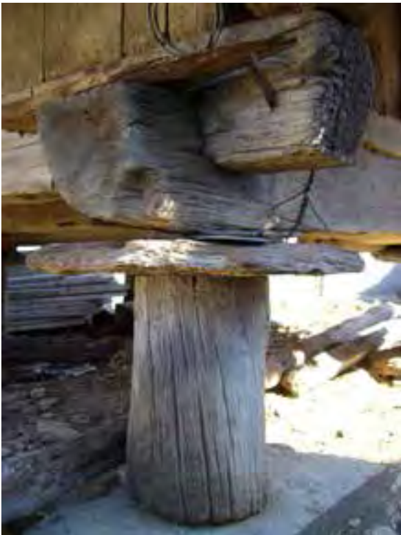
FIG. 13.06 Pegollo cilíndrico de madera. Laguna_01 (L11).
