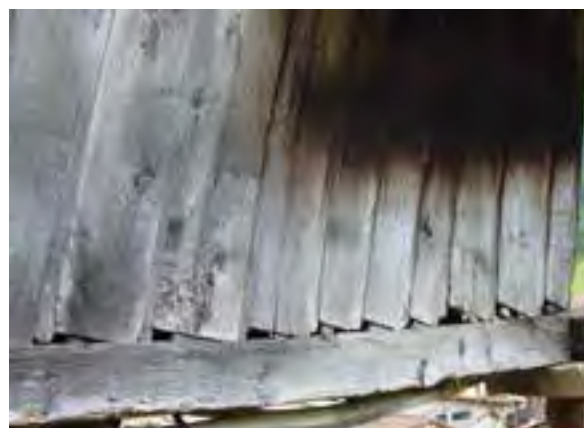
FIG. 13.42 Lengüetas y espigas en un lienzo deformado. Villar de Vildas_26 (A08_04).
