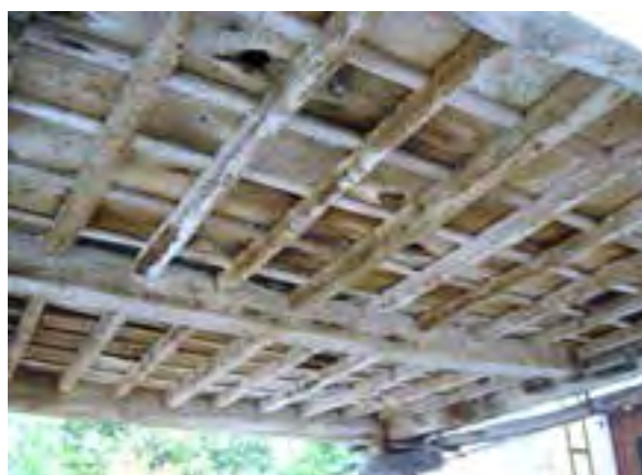
FIG. 08.032 Suelo complejo de viga central, viguetas y listones. Casomera_10 (A04_02).
