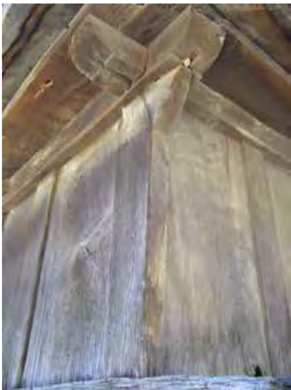
FIG. 08.042 Esquina en ménsula (endemismo local). Sotelo_01 (L11).
