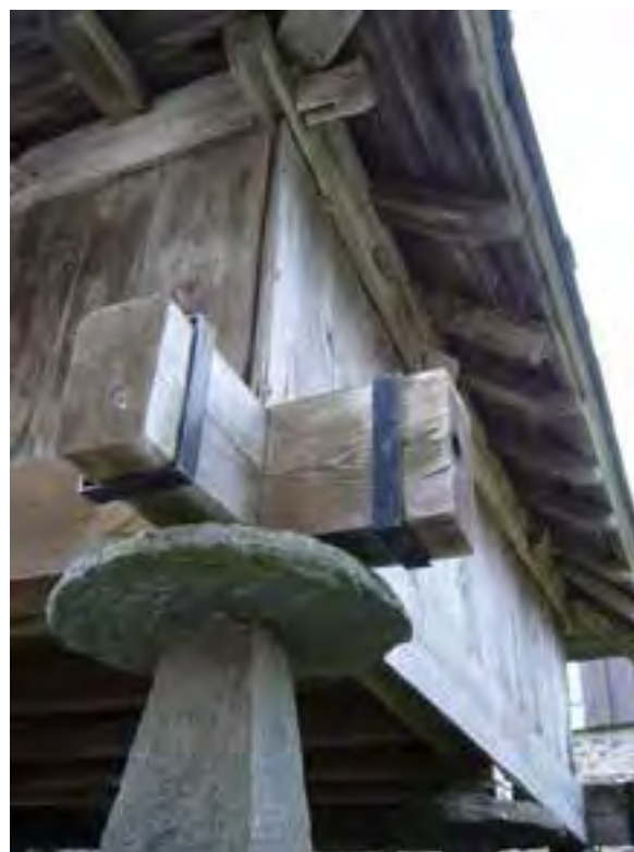
FIG. 13.16 Traveses poderosos, con abrazaderas en las cabezas. El Puerto_02 (A09_04).
