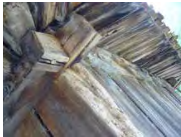
FIG. 08.055 Liños con ranuras para el ensamble de las colondras y clavos de madera. Los Llanos_05 (L03).
