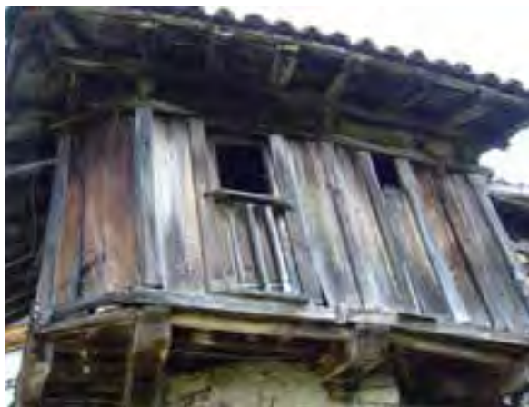
FIG. 06.10 Construcción de madera en Belerda (A03_01).
