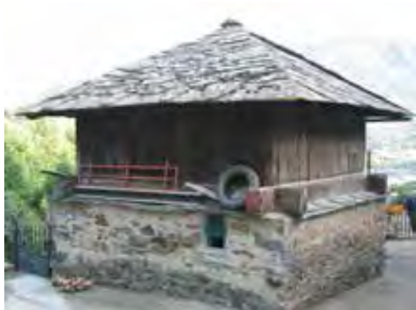
FIG. 06.29 San Miguel de Laciana_08 (L07). Plinto coronado por un tornarratas.
