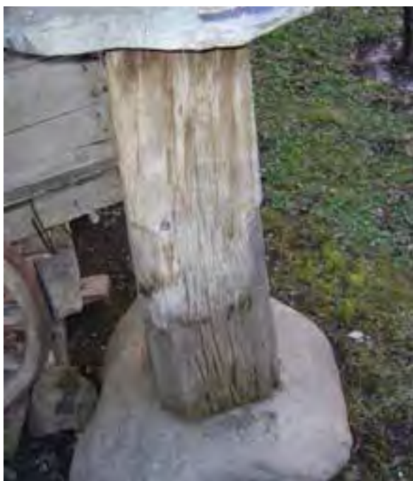
FIG. 08.005 Ajuste entre pegollo de madera y solera. Caldevilla_05 (L03).
