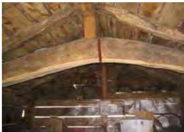
FIG. 08.077 Curbatón con un enano apeando la viga de cumbre. Posada de Valdeón_08 (L03).
