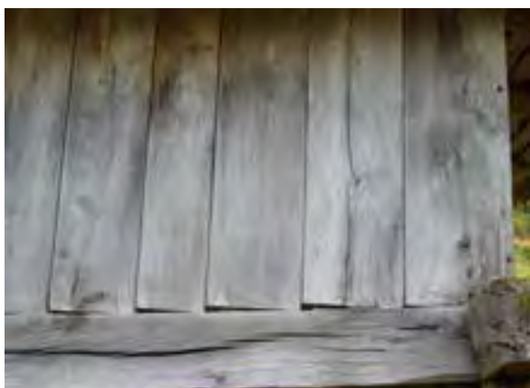
FIG. 13.41 Espigas en un lienzo deformado. Perlunes_13 (A08_03).
