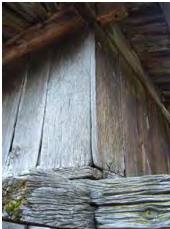
FIG. 13.45 Esquina de colondras a tope. Pola del Pino_03 (A04_01).
