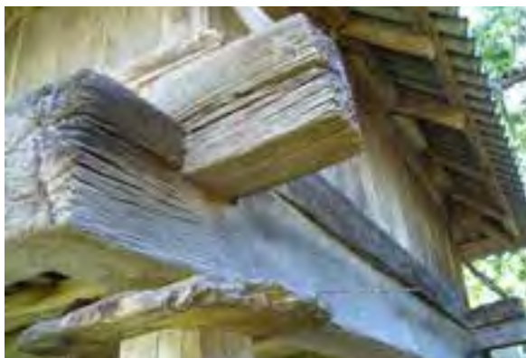
FIG. 08.026 Traveses resaltados con ensamble incompleto. Porcis_01 (G01).
