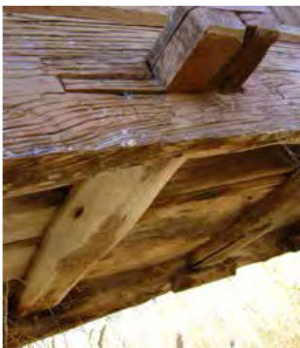
FIG. 13.28 Ensamble parecido en un hórreo-secadero gallego. Forxa, Orense.
