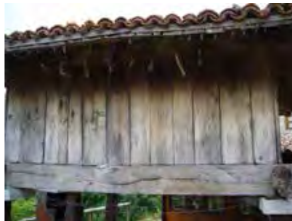
FIG. 12.29 Caja de hórreo sin bastidor. La Focella_07 (A07_01).
