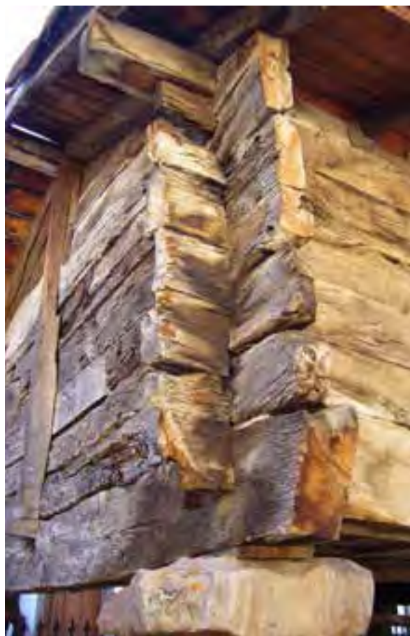
FIG. 12.26 Ensamblajes en caja. Soto de Valdeón_17 (L03).
