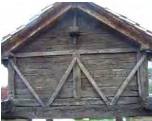
FIG. 13.36 Riostras en un hórreo con bastidor. Riaño_01 (L02).
