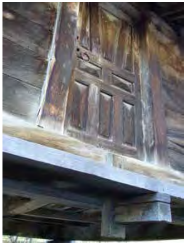
FIG. 08.116 Escuadra de madera ensamblada. Soto de Valdeón_01 (L03).
