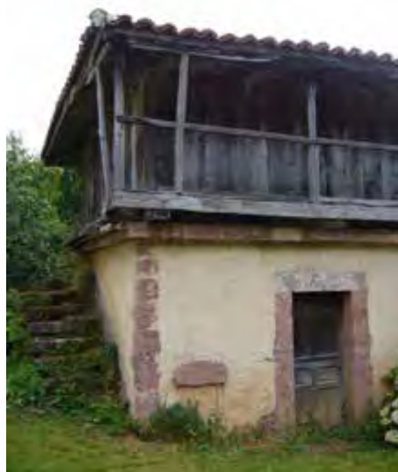
FIG. 06.28 Barrio_07 (A07_02). Plinto coronado por un tornarratas.
