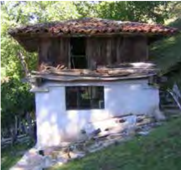
FIG. 06.30 Oseja de Sajambre_13 (L04). Plinto añadido.
