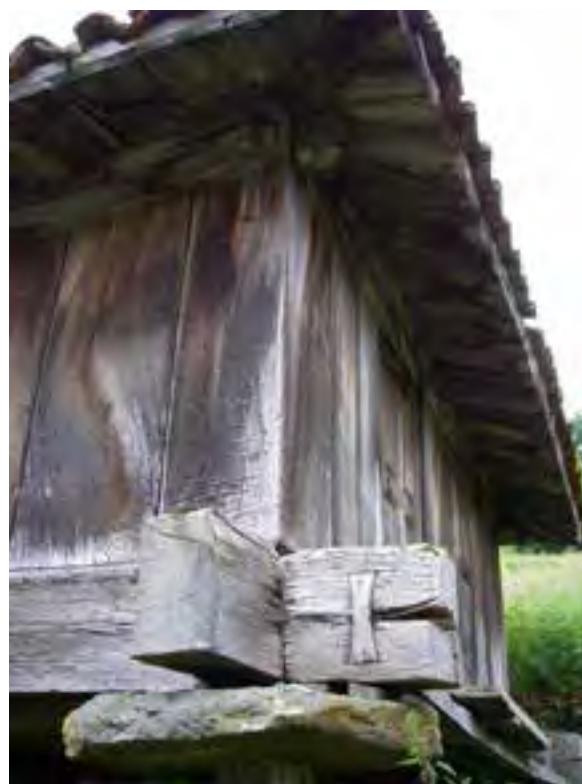
FIG. 13.17 Cabeza de traves cosido con una cola de milano. Lindes_01 (A06_01).
