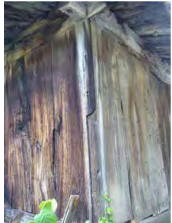
FIG. 08.041 Engüelgo por ensamble de colondras (endemismo local). Murias_04 (A04_03).
