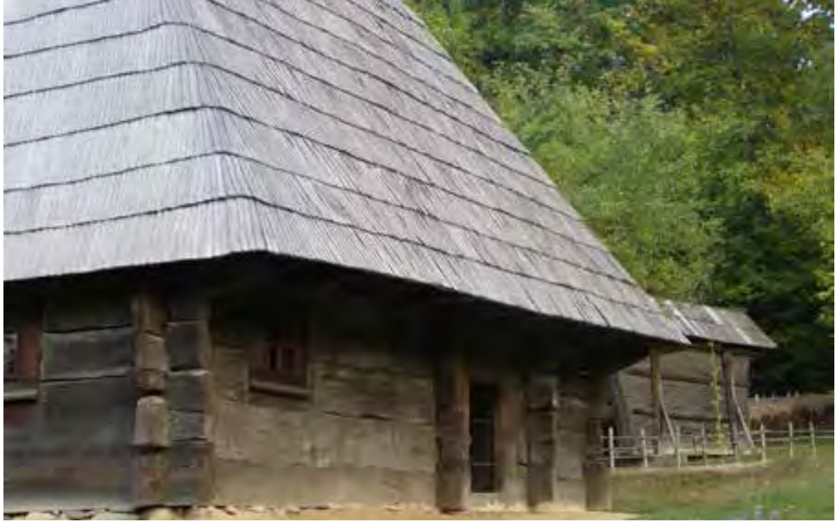
FIG. 12.09 Construcción de tablonos ensamblados. Museo etnográfico Astra (Rumanía).
