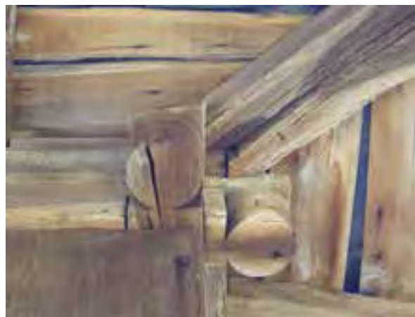
FIG. 06.44 Meroy_01 (L06). Moldura en la cabeza de los liños.
