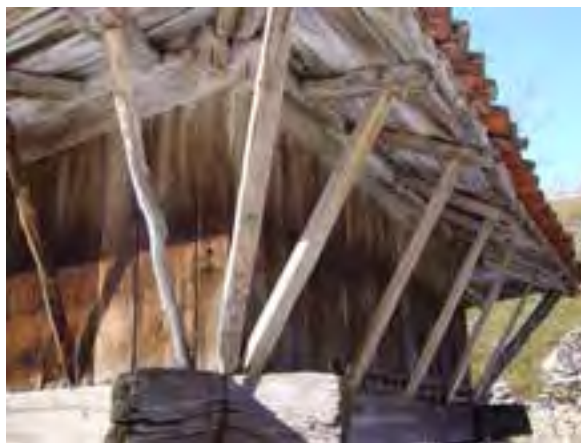
FIG. 08.088 Tentemozos sistemáticos, desde el trabe. Torrestío_03 (L06).
