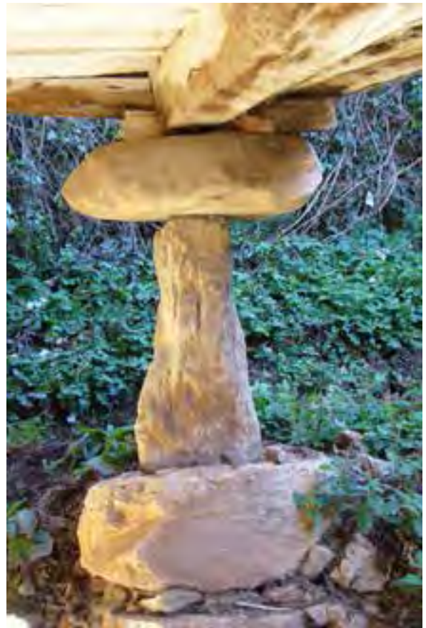
FIG. 08.018 Tornarratas esférico (excepción). Aguino_04 (A08_03).
