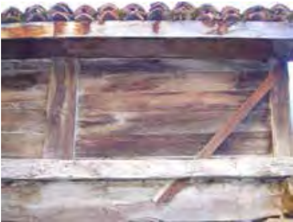
FIG. 12.20 Pared de la caja en un hórreo con bastidor. Caldevilla_05 (L03).
