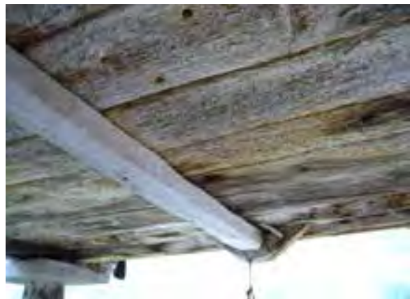
FIG. 13.26 Sobigaño colgado del trabe. Villar de Vildas_28 (A08_04).
