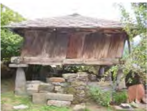
FIG. 13.31 Caja deformada. Orallo_05 (L07).
