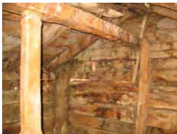
FIG. 08.065 Tirante simple (T1) ensamblado con pinacho. Acebedo_02 (L02).
