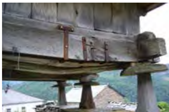
FIG. 13.18 Apósito en trave roto. Brañas de Arriba_04 (A09_04).
