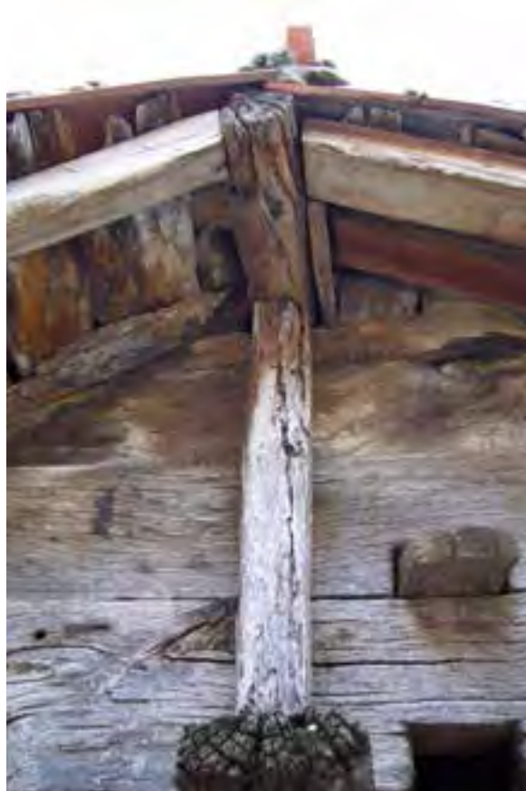
FIG. 08.076 Cumbre apoyada sobre un pinacho. Felechás_03 (L02).
