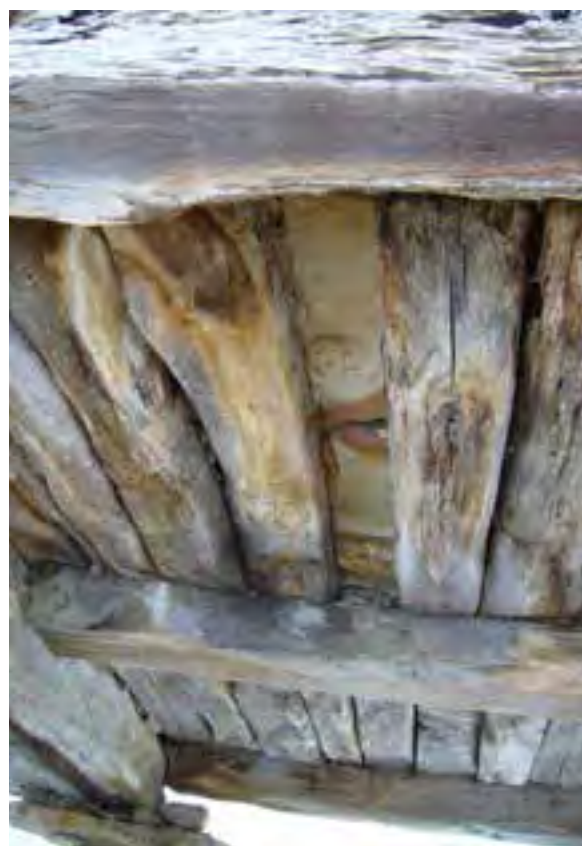
FIG. 06.49 Las Bodas_01 (L02). Suelo blindado con losas de piedra.
