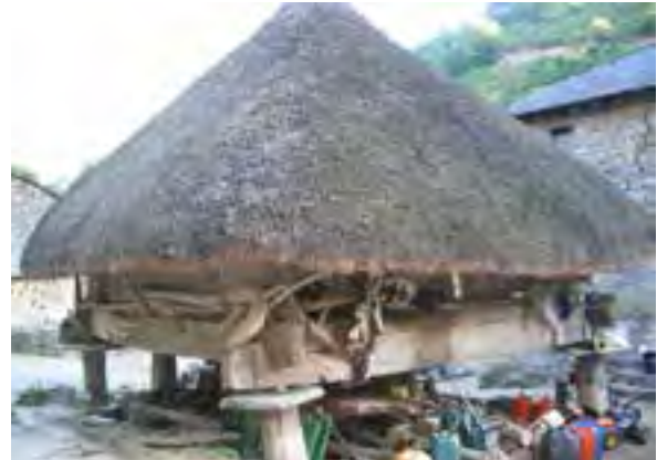
FIG. 13.08 Hórreo con cubierta de paja y un pegollo desplomado. Bargelas_01 (L11).
