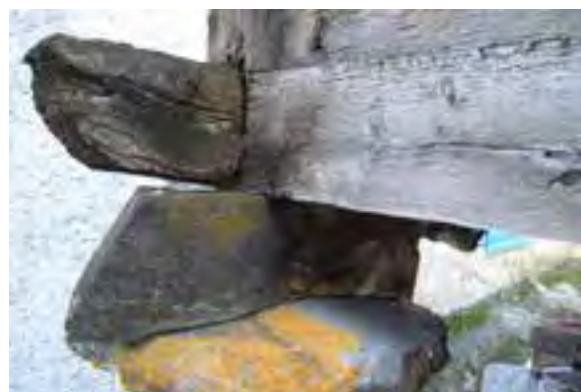
FIG. 08.020 Calzo grande y adaptado al tornarratas (excepción). Santa Marina_01 (L03).
