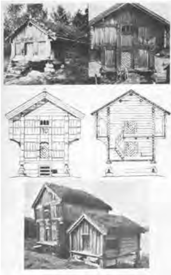
FIG. 04.06 Construcciones en Noruega (Loft), elevadas y de tablonos ensamblados. Cobijo, p. 23.
