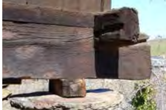
FIG. 08.019 Calzo de madera. Cela_01 (L11)
