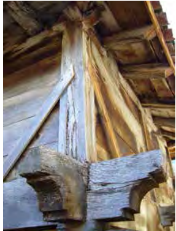
FIG. 08.029 Testa moldurada. Prada_03 (L03).
