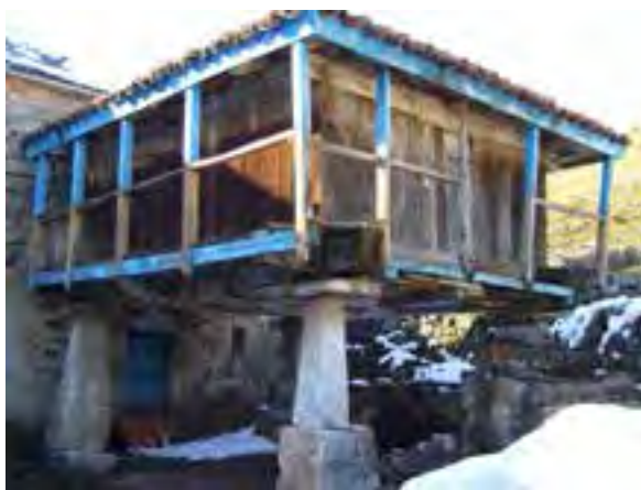
FIG. 08.120 Corredor elemental de 2 lados. Torrestío_04 (L06).
