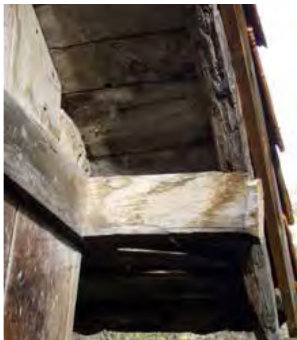
FIG. 08.054 Extremo de liño en vuelo. Oseja de Sajambre_02 (L04).
