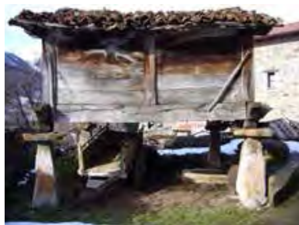
FIG. 08.047 Tablas en horizontal encajadas en el bastidor. Santa Marina_11 (L03).
