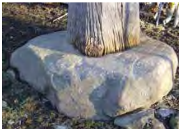
FIG. 08.003 Solera sobresaliente. Caldevilla_02 (L03).
