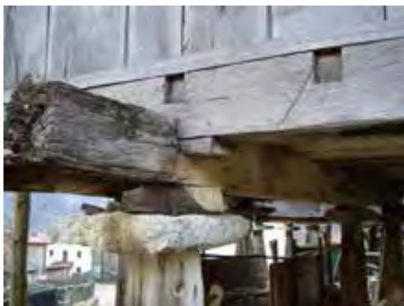
FIG. 13.20 Trabe reutilizado, con los rebajes originales. Oseja de Sajambre_06 (L04).
