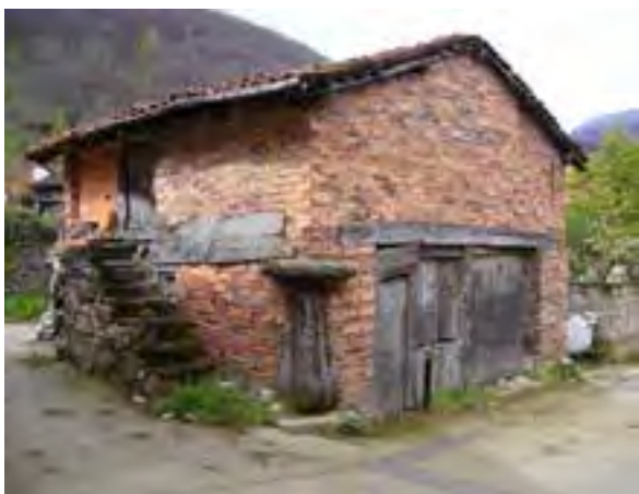
FIG. 06.13 Construcción a partir de un hórreo en Bezanés (A03_01).
