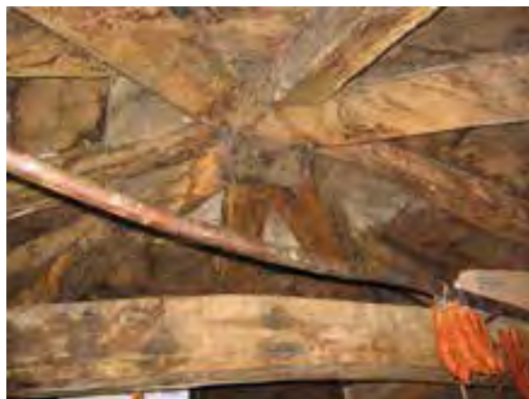
FIG. 13.47 Convergencia de los aguilonos sin apoyo central. Cordiñanes_01 (L03).
