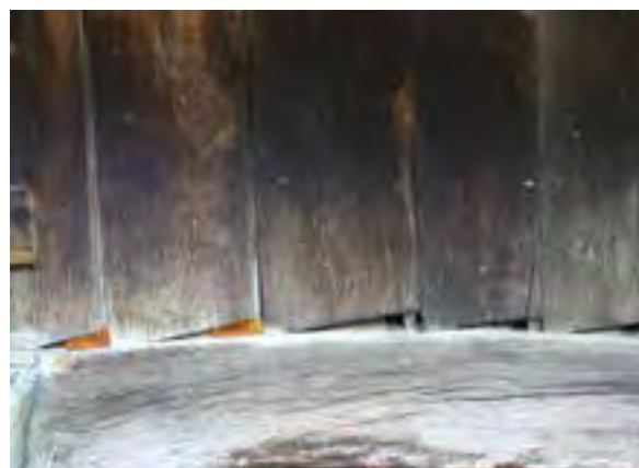
FIG. 13.40 Lengüetas y espigas en un lienzo deformado. Perlunes_04 (A08_03).
