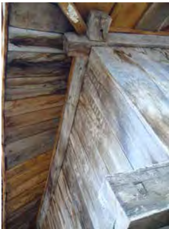
FIG. 13.55 Tablero de cubierta a base de tablonos. Oseja de Sajambre_18 (L04).
