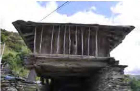
FIG. 08.090 Tentemozos verticales. Brañas de Abajo_04 (A09_04).
