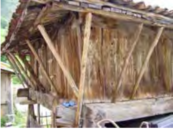
FIG. 08.089 Tentemozos sistemáticos. Tuiza_01 (A05_02).
