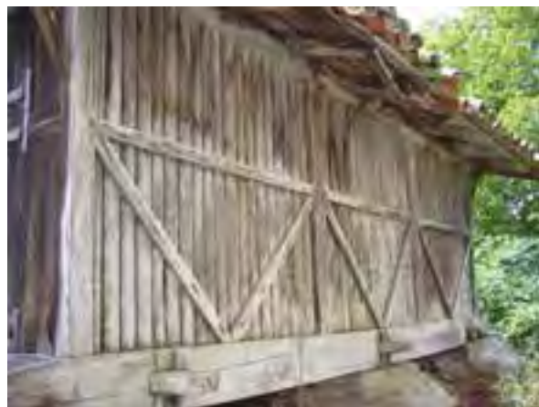
FIG. 13.54 Arriostramiento sistemático en un hórreo-secadero. Fuentemoura, Orense.
