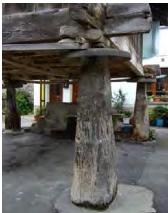
FIG. 08.004 Solera plana. Casomera_16 (A04_02).
