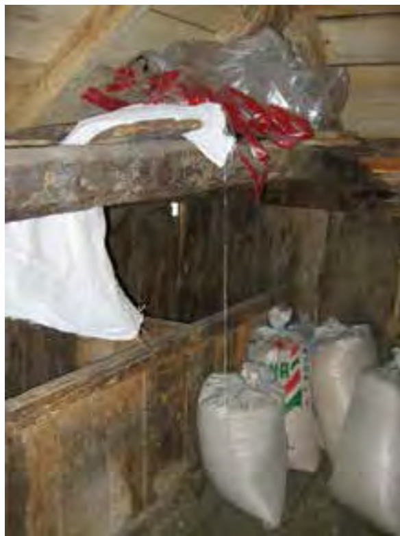
FIG. 06.51 Sosas_03 (L07). Troje obsoleto por el acopio en saco.
