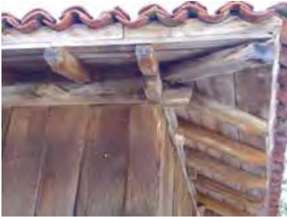
FIG. 08.097 Mandil recortado. Torrestío_05 (L06).
