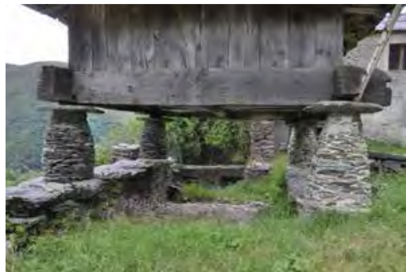
FIG. 08.012 Pegollo de fábrica de mampostería. Brañas de Abajo_02 (A09_04).
