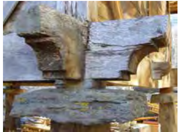
FIG. 06.38 Prada_03 (L03). Molduras en la cabeza de los traves.
