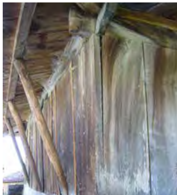
FIG. 13.44 Pseudoengüelgo abierto por el desplome de una cara. Hórreo en Prieres, Caso (fuera del área de investigación).
