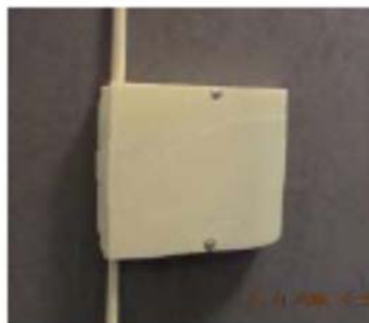
Figura 33: Caja de derivación en planta. Fuente: [CMT6]
