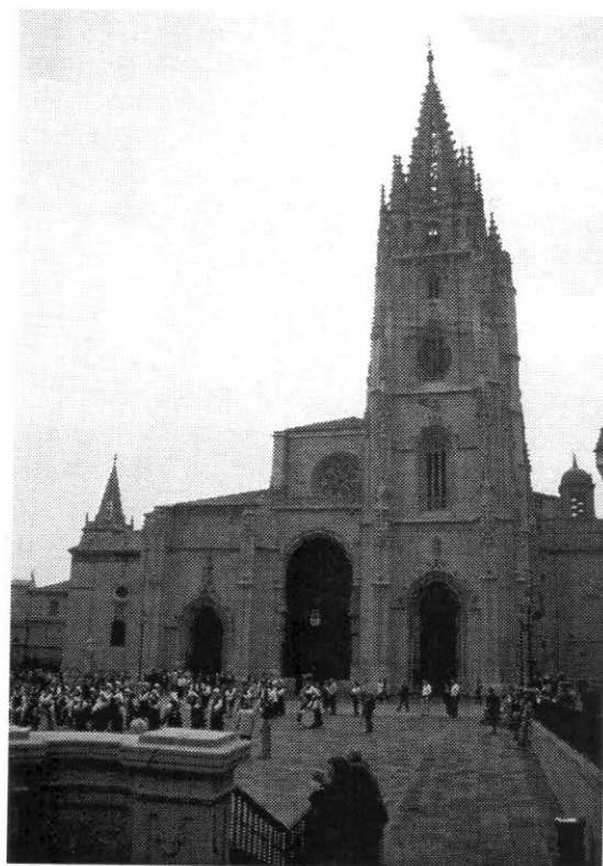
Imagen 1. Frente de la catedral de Oviedo con el pórtico y la torre sur. Al proyecto original se le añadió, finalmente, el cuerpo alto y la flecha proyectados por Rodrigo Gil de Hontañón después de que un rayo derribase la anterior en el último cuarto del siglo XVI. Esa parte alta no será tenida en cuenta en este análisis.
