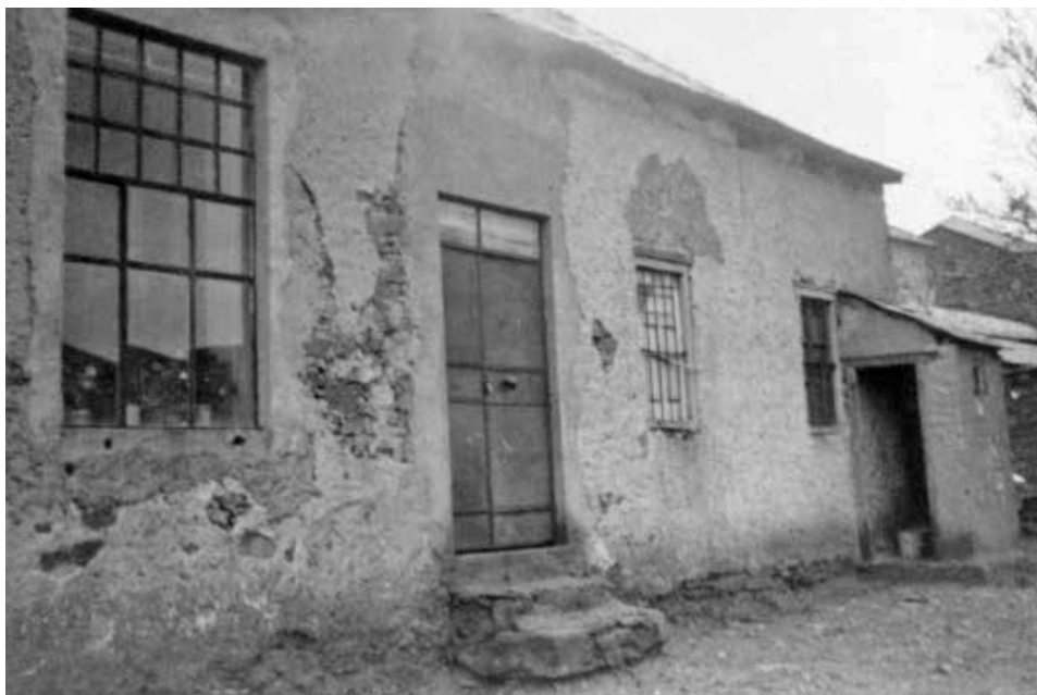
ILUSTRACIÓN 2. Escuela de Montealegre. Año de construcción 1896. Archivo Histórico Provincial de León.
