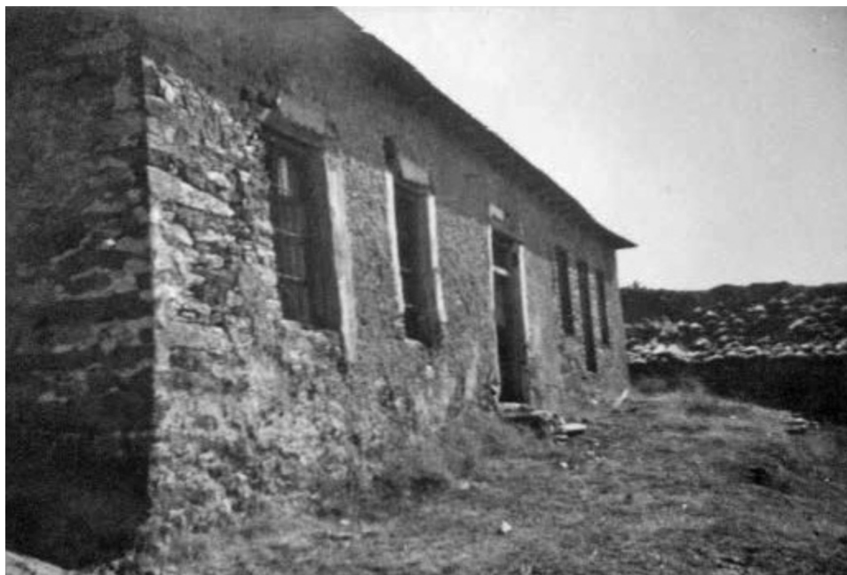
ILUSTRACIÓN 8. Escuela de Villar de los Barrios de Nistoso. Año de construcción 1930. Archivo Histórico Provincial de León.
