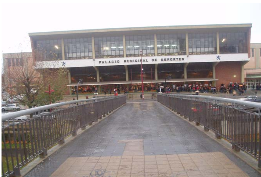
Vista panorámica frontal del Palacio de deportes de León. Fuente: Roberto Cachán.
