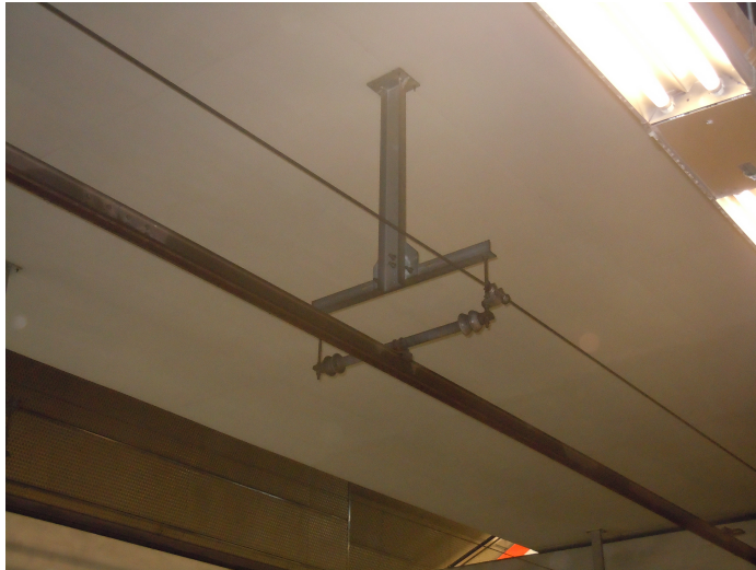
Figura 5.1: Sistema de catenaria rígida tipo T
