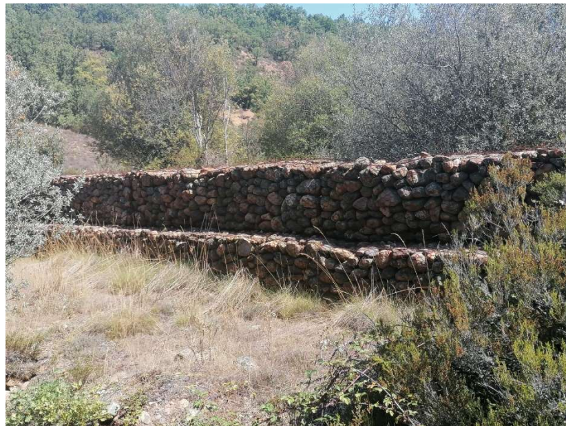
Imagen n° 4.8.1 Diques de gaviones en el arroyo del Valle de la Villa (Fuente: Elaboración propia)
