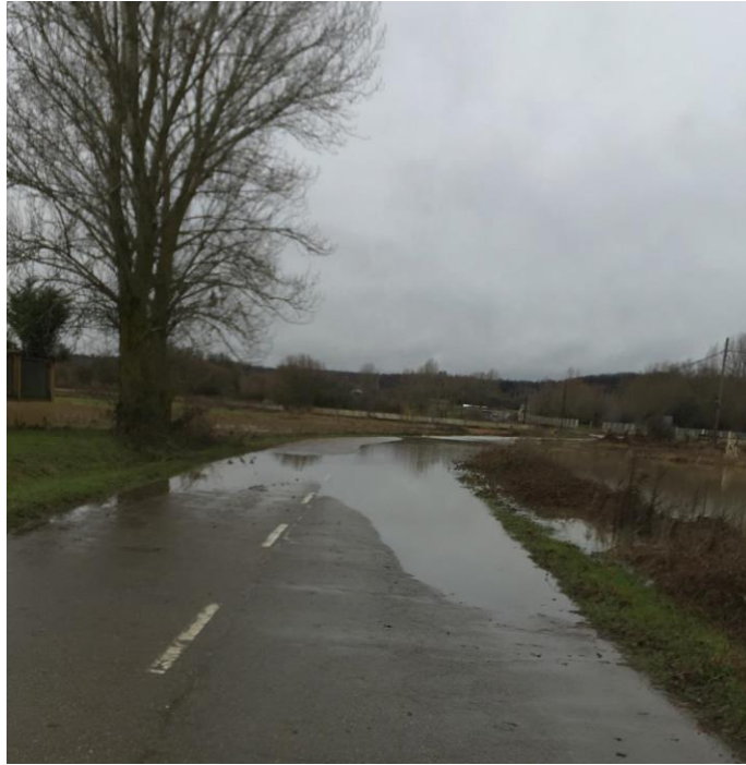
Imagen 3. Carretera LE-4610 que conecta Devesa de Curueño con Vegas del Condado (20/12/19). Fuente: Elaboración propia
