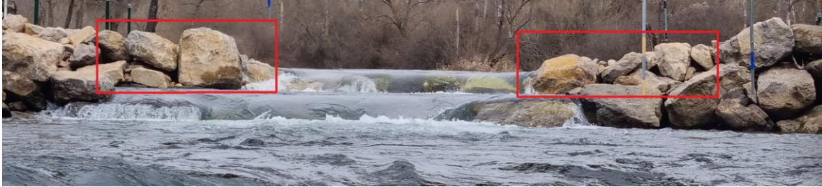
Figura 5.3-7. Colocación de los espigones para la generación de un rulo.
