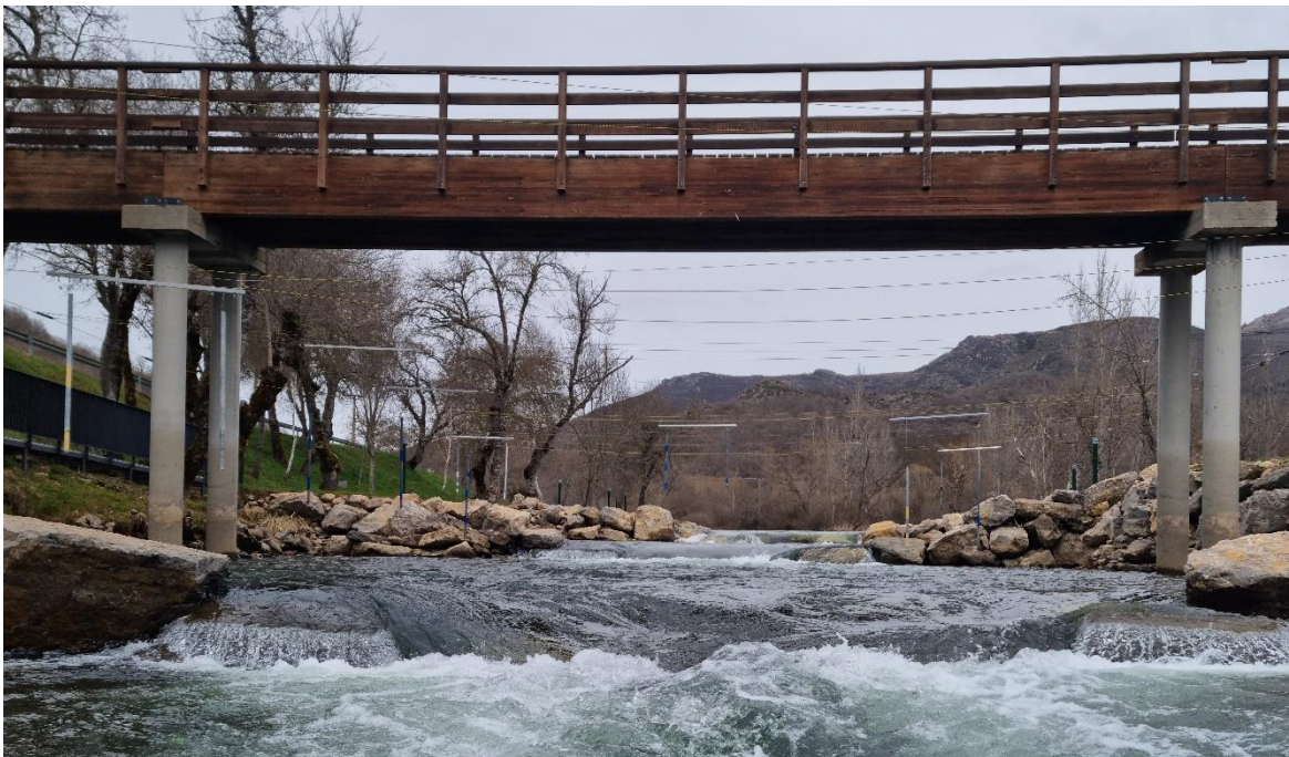
Figura 5.2-1. Tramo inicial del circuito.
