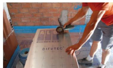
Con el fin de garantizar una correcta instalación de estos sistemas radiantes, una óptima aplicación del mortero y una alta calidad en el acabado final, utilice los tacos ALB para fijación mecánica tanto en las esquinas como en los paneles perimetrales de las estancias.
