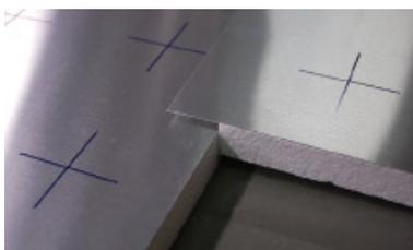
3. En los remates a final de línea o en la última línea, el panel debe ser cortado con una herramienta tipo radial o cuchilla para seccionar el aluminio.
