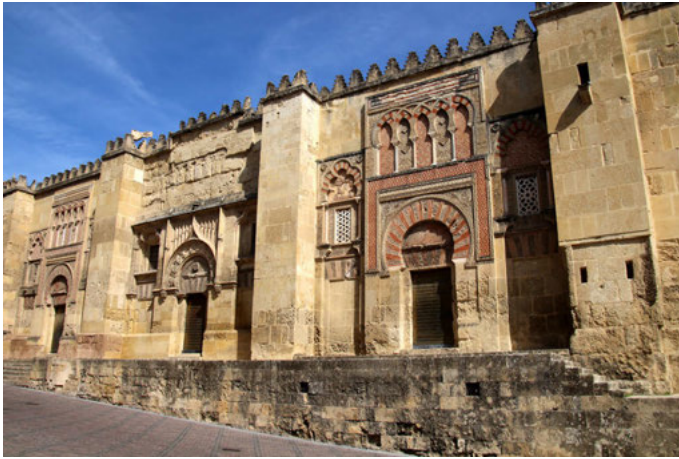
Fig. 1. Mezquita de Córdoba desde el ángulo suroeste. Fotografía del autor.
