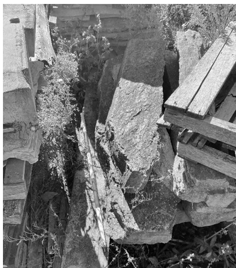
11. Piezas prismáticas que cubrían el techo del acueducto.
