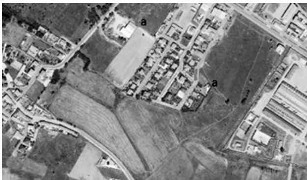
5. Vista área de la zona de Valdeviejas-Peñicas en la actualidad; “a”: trayectoria del canal.
