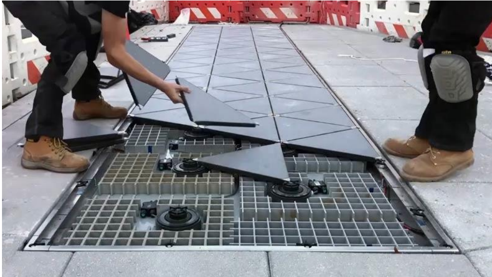
Figura 9.5 Baldosas piezoeléctricas (Fuente: [51])
