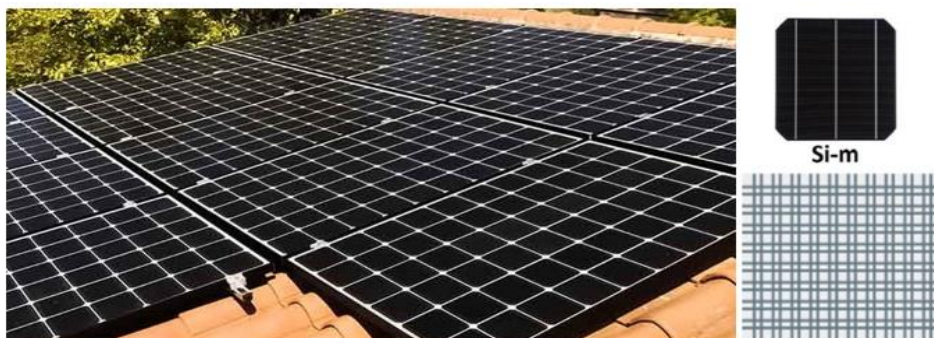
FIGURA 3.3 Ejemplo placa solar monocristalina y estructura atómica (Fuente: [38])
