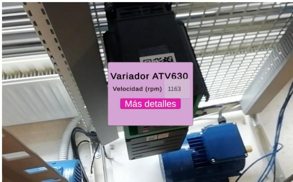
*Figura 7. 1 Menú inicial del variador visto desde la pantalla de la Tablet*
