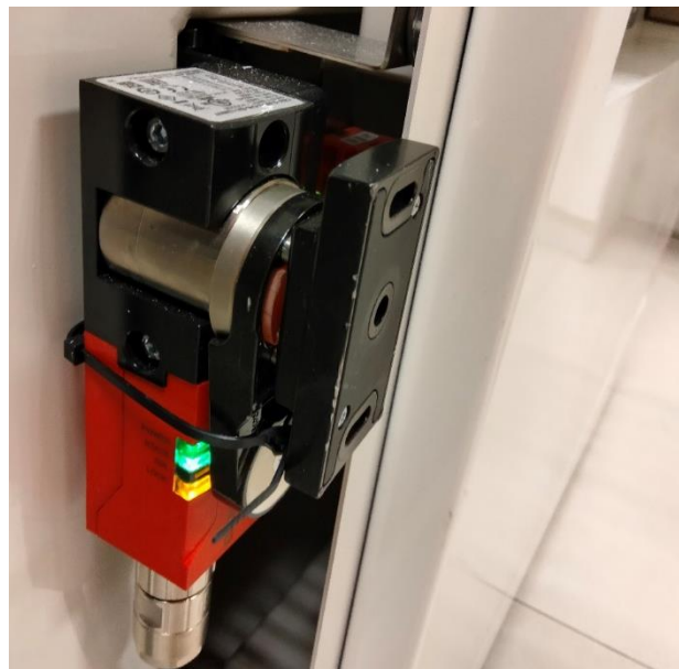
Figura 2.8: Electroimán y pieza de la puerta unidos con bridas. Fuente: Elaboración propia.
