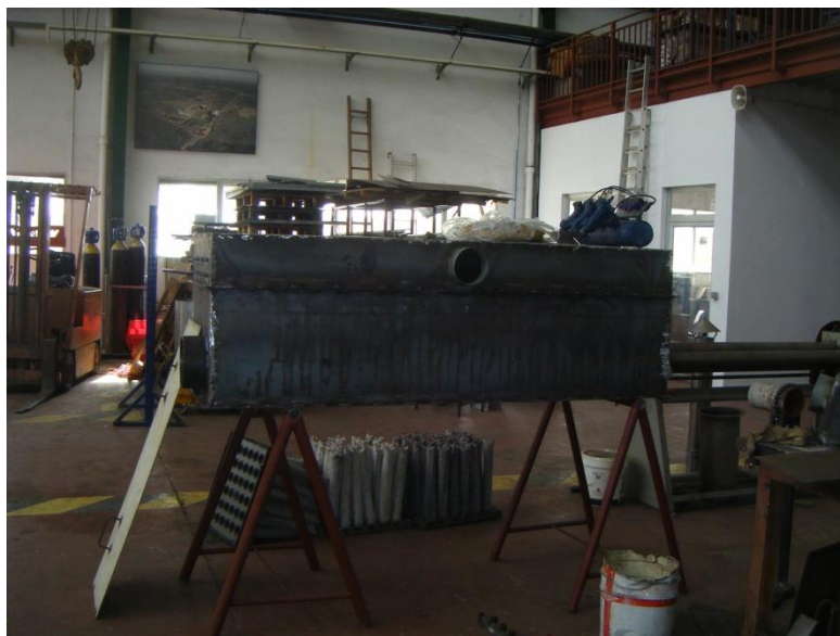
Figura 5.6.1.- Estructura de chapa de hierro del filtro de mangas en fase constructiva.
