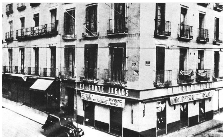
Figura 2.1: Fachada de El Corte Inglés de Calle Preciados de Madrid (1940).
