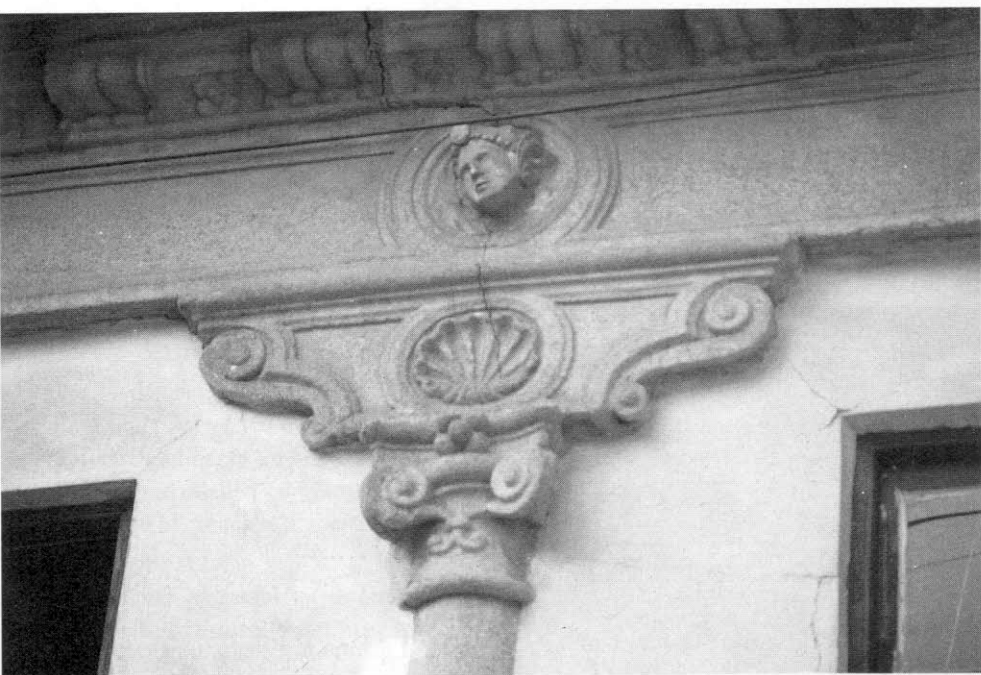
Lámina 4. Patio, piso superior. Detalle.
