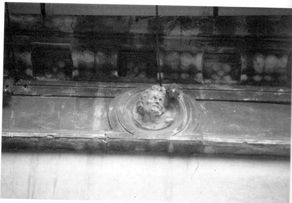
Lámina 5. Patio, piso superior. Detalle.
