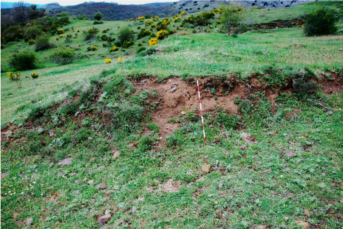
Imagen 13. Corte de una terraza agraria en La Canga realizado en la adecuación del terreno para el paso de camiones.
