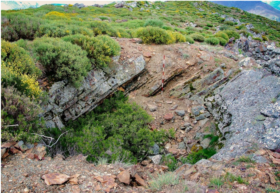
Imagen 35. Casamata destruida y parte del parapeto.
