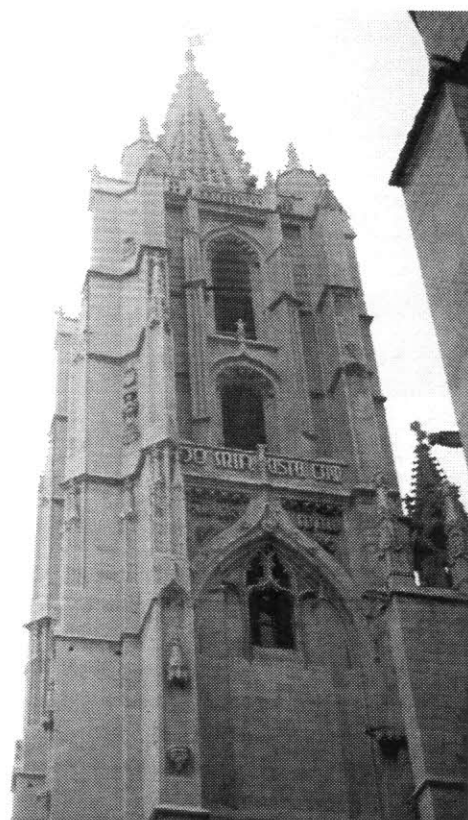
Imagen 5. La torre sur de la catedral de León presenta un evidente replanteo. Literalmente se ha "embutido" la zona alta, que sirve de base a la flecha, sobre un proyecto anterior. Este remate ha sido atribuido a Hans de Colonia.
