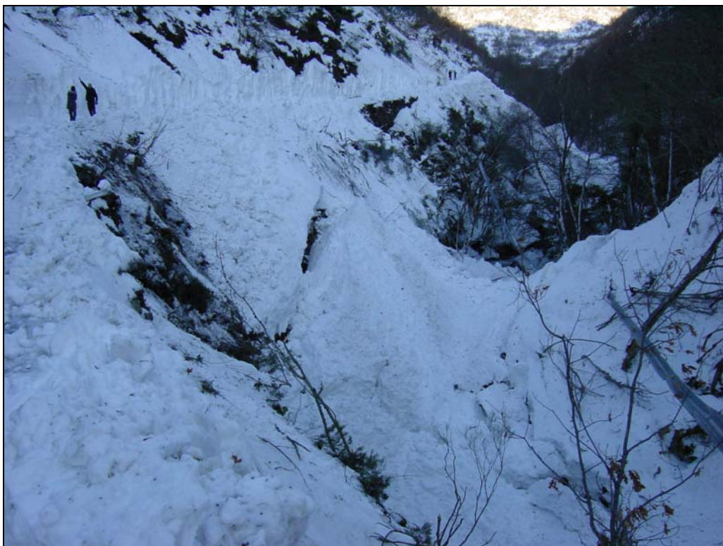
Figura 328. Alud de fondo en El Calzadón, en la carretera de acceso a Salientes. El río Valseco discurre bajo la nieve en la parte derecha de la fotografía. Nótese la presencia del guardarraíl en la ladera opuesta de la carretera y la gran cantidad de árboles derribados. Varias personas como escala. 18-12-2008.
