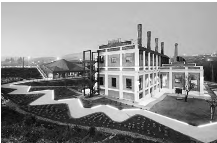
Figura 1. Ene.térmica, primera de las instalaciones museísticas de Ene.Museo Nacional de la Energía.
