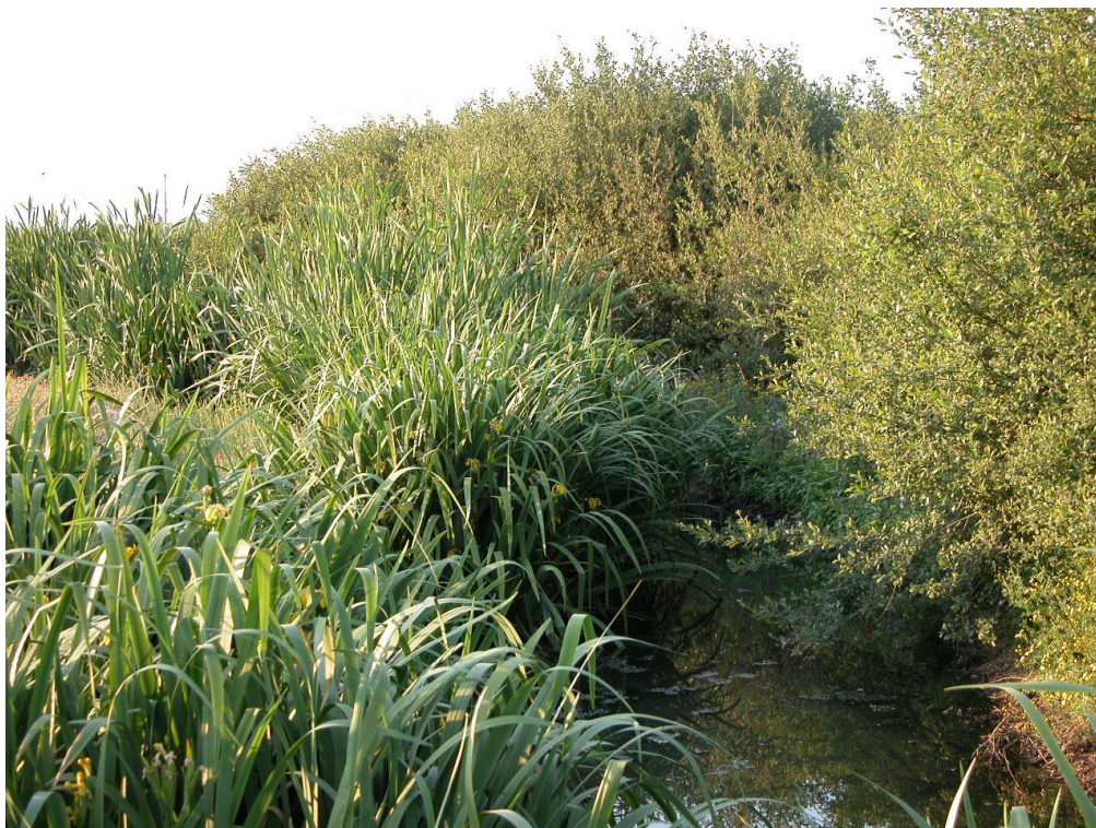
Figura 2.7. Etapa con Iris pseudacorus (flujo superficial) y Salix atrocinerea con flujo subsuperficial. De la depuradora de tipo MJEA ® de Bustillo de Cea.
