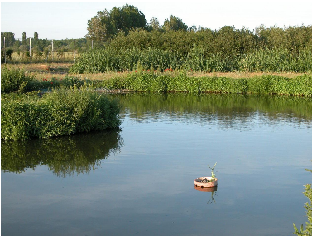
Figura 2.4. Laguna de micrófitos la depuradora de tipo MJEA ® de Bustillo de Cea.
