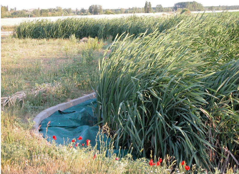
Figura 2.5. Balsa con Typha latifolia y flujo hidráulico superficial. De la depuradora de tipo MJEA ® de Bustillo de Cea. (Vista de la entrada).
