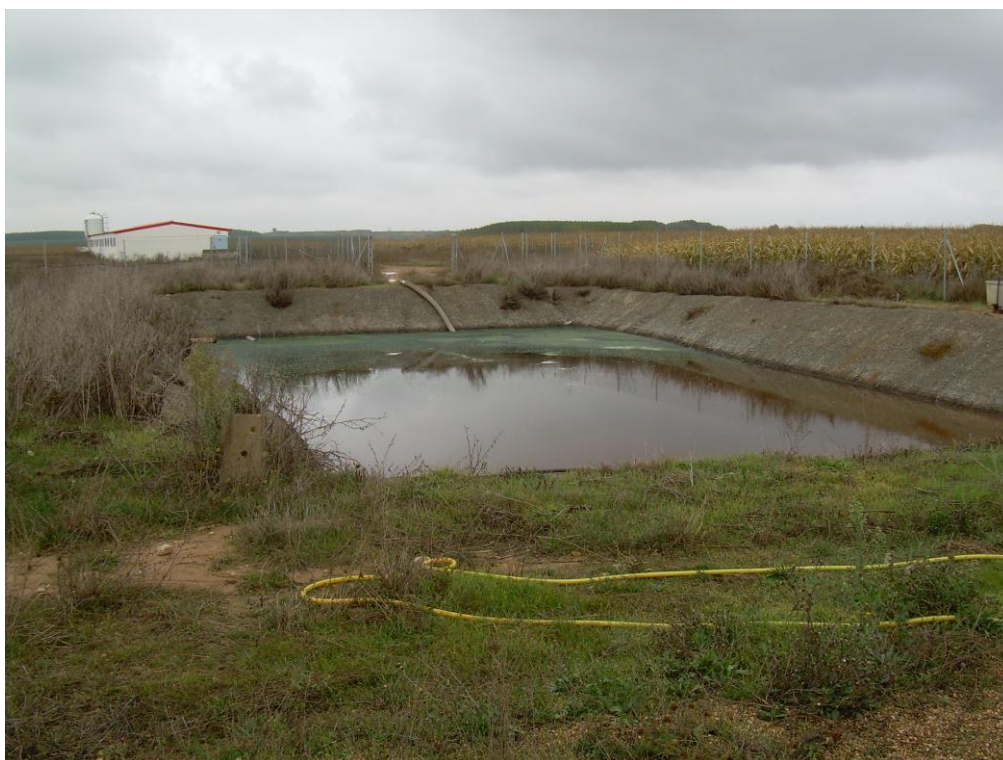
Figura 2.11. Laguna de pretratamiento o Balsa de almacenamiento de los purines. Del sistema de depuración piloto de Centrotec.
