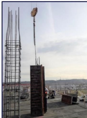
Figura 26. Encofrado del pilar. Fuente: Propia.
