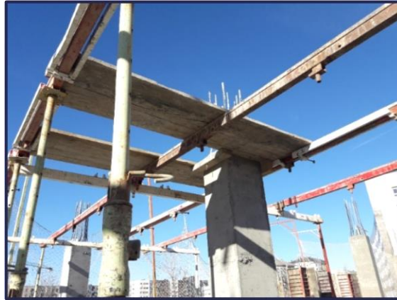
Figura 31. Paso 2: Colocar las maderas. Fuente: Propia.
