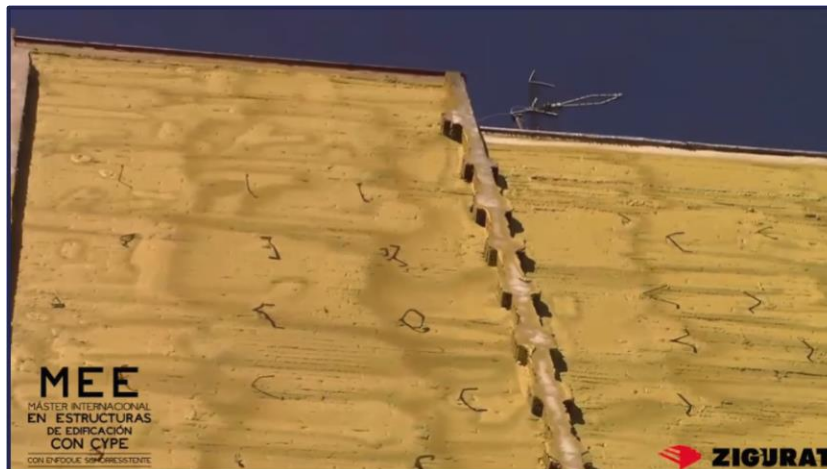
Figura 5. Muros de Pantalla. Fuente: Zigurat. YouTube
