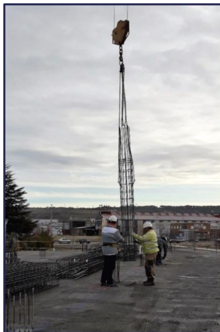
Figura 9. Colocacion de los pilares sobre las esperas. Fuente: Propia
