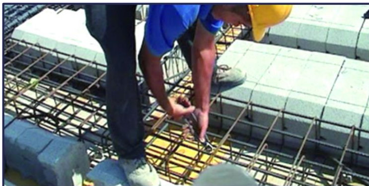
Figura 17. Reforzado de la ferralla. Fuente: líneapreencion.com
