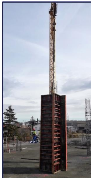
Figura 11. Encofrado de pilares. Fuente: Propia
