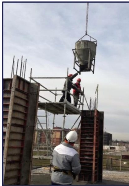
Figura 28. Cogiendo el cangilón para hormigonar. Fuente: Propia.
