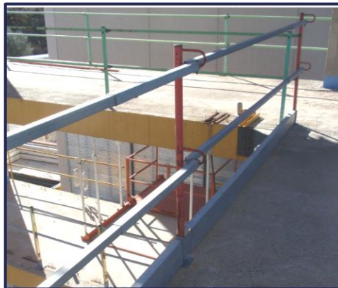
Fotografía 39. Barandilla montada con rodapié y póster. Fuente: Lineaprevencion.com
