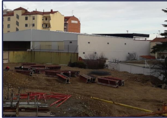
Figura 24. Moldes montados. Fuente: Propia.
