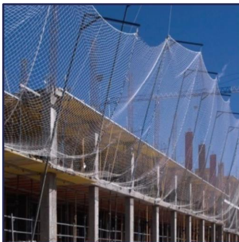
Fotografía 36. Aspecto final. Fuente: Propia
