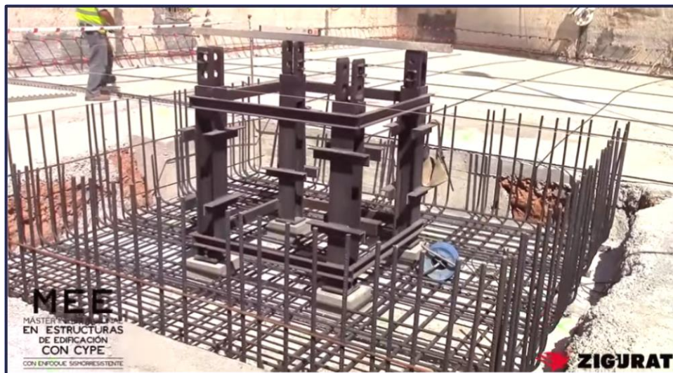
Figura 7. Colocación de la grúa. Fuente: Zigurat. YouTube
