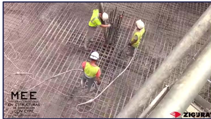
Figura 8. Proceso de hormigonado y vibrado. Fuente: Zigurat. YouTube
