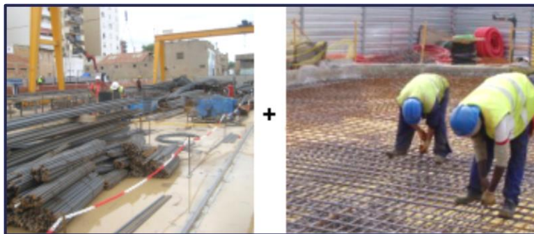
Figura 16. Colocación de la ferralla. Fuente: Generados de precios
