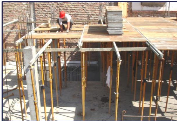
Figura 32. Operario colocando las maderas. Fuente: Línea Prevención.
