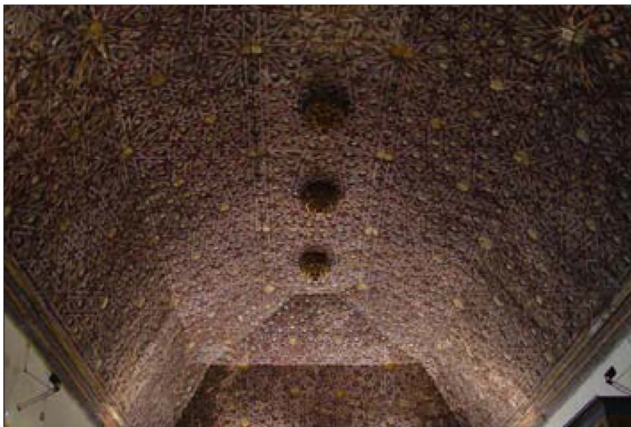
■ Fig. 4. Armadura de madera de la nave. Santa Colomba de la Vega.
