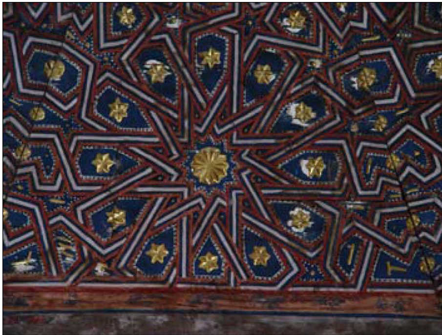
■ Fig. 9. Estrella sencilla de 12 puntas formada por taujeles unidos mediante un encajado a agudo. Azares..
