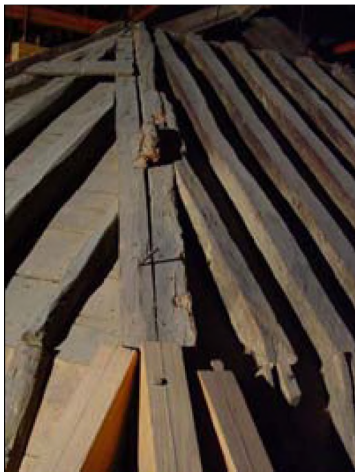
■ Fig. 3. Encuentro entre limas y ensamble a garganta y quijada.
