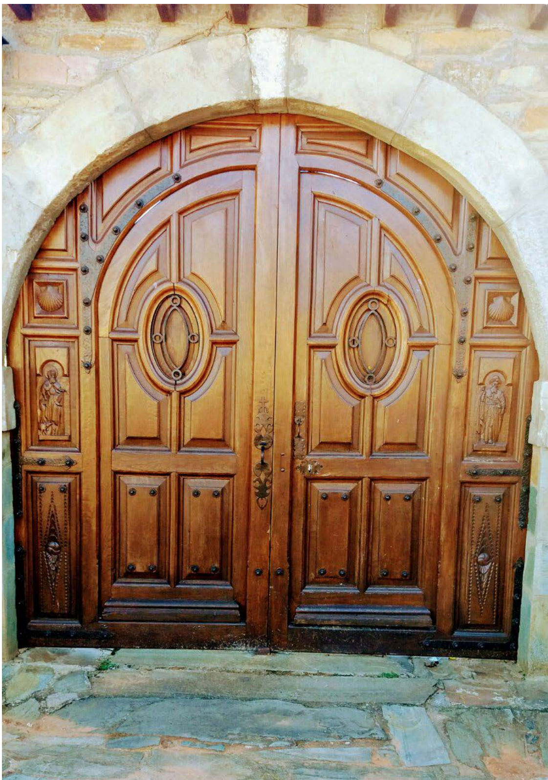
9.- Puerta del antiguo hospital de San Antonio Abad, conservada en la actualidad en Castrillo de los Polvazares.
