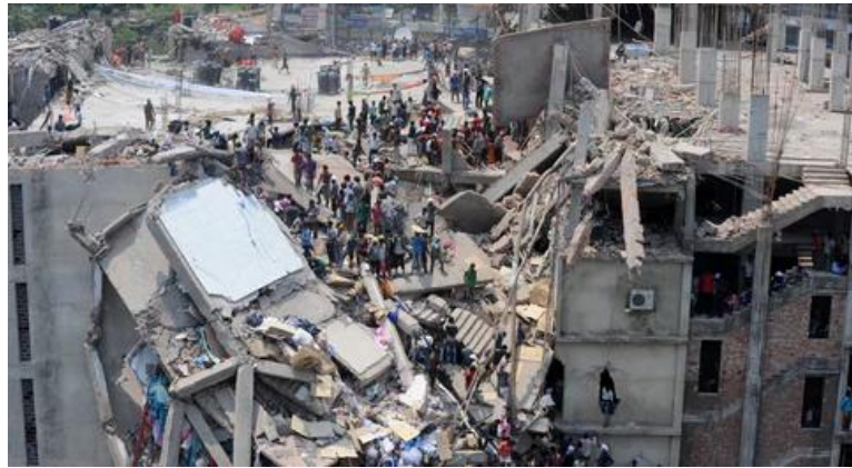
Figura 4.5 Imagen del derrumbe de la fábrica de Rana Plaza en Bangladesh.
