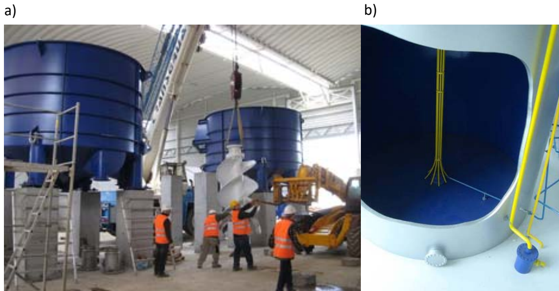
Figura 1.7 Sistema BTA. a) Agitación mecánica; b) Agitación mediante recirculación de biogás (BTA International, 2017)
