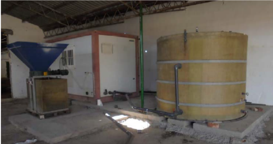
Figura 6.5 Unidad de pretratamiento y digestor principal
