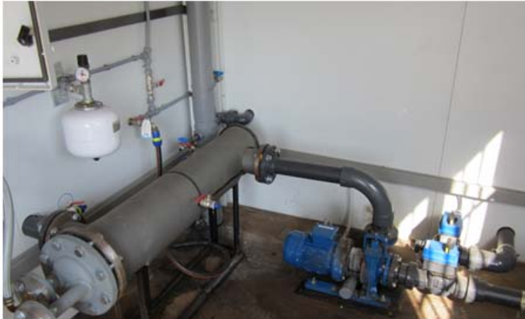
Figura 6.6 Intercambiador de calor. a) Integrado en el sistema de calefacción; b) Desmontado
