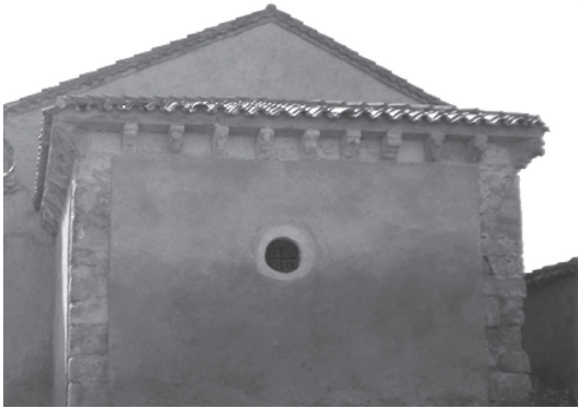
Fig. 1. Vista exterior de la capilla de la iglesia de Santo Tirso de Villahibiera y de la capilla de la iglesia de Nuestra Señora de la Asunción de Villarmún, León. Fotografías del autor.
