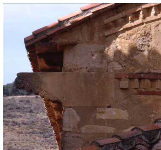
■ Lám. 20. San Miguel de Escalada. Angulo sureste de la nave central..
