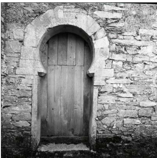
■ Lám. 25. Santiago de Peñalba. Puerta lateral.
