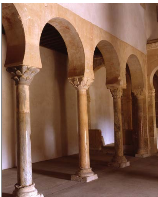
■ Lám. 17. San Miguel de Escalada. Detalle del intercolumnio septentrional.
