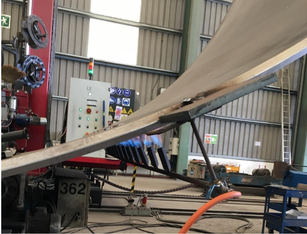
Figura 11. Detalle del tratamiento térmico de precalentamiento para la unión de una de las soldaduras de prueba.
