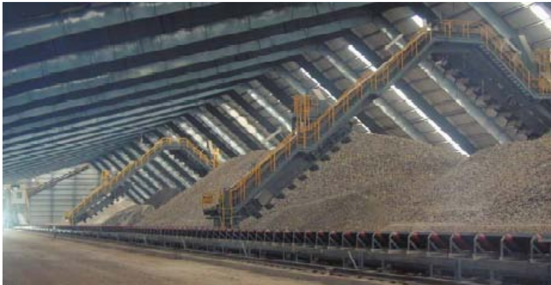
Figura 1.9. Vista Parque de Prehomogeneización
