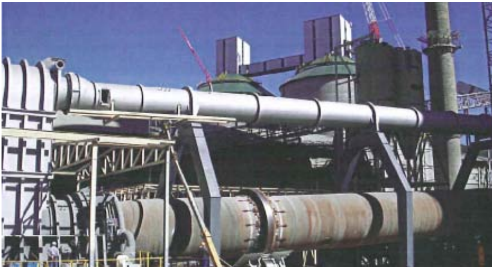
Figura 1.29. Vista del Horno rotativo
