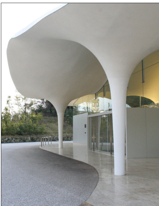
■ Fig. 4. Toyo Ito. Crematorio Meiso no Mori del cementerio de Kakamigahara (detalle de los pilares) . 2005-2006. Kakamigahara (Japón). (Fotografía: Yuco).
