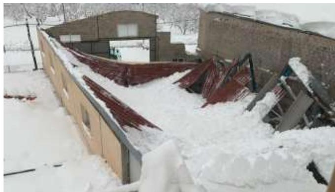
**Figura 2. Hundimiento del tejado de una nave industrial de Fuentespalda (Rajadel, 2020).**
