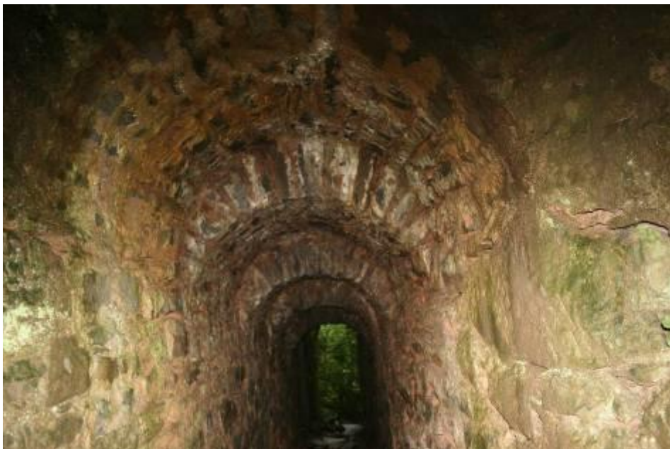
Ilustración 53. Alcantarilla para el Reguero Canales por debajo de la trinchera del nivel 456.
