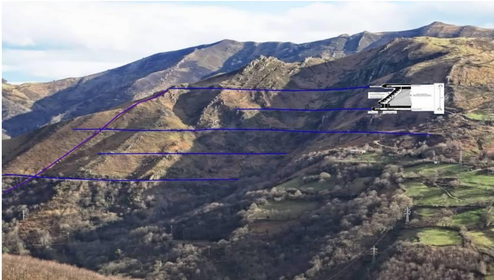
Ilustración 34. Explotación por pisos en el valle de Canales.
