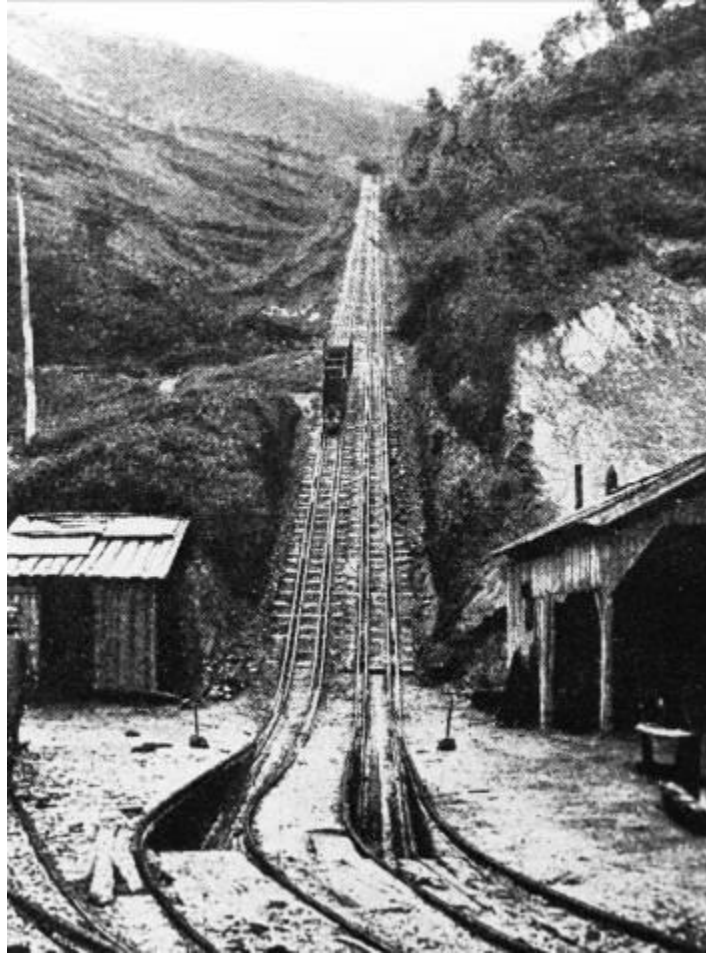
Ilustración 63. Plano inclinado número 4, del tipo “de gochu”. (Loredo) Transcurría del nivel 100 al 12,50. Fuente: Sociedad Anónima Minas de Riosa. La Esfera . (Número especial dedicado a Asturias), Julio de 1918.
