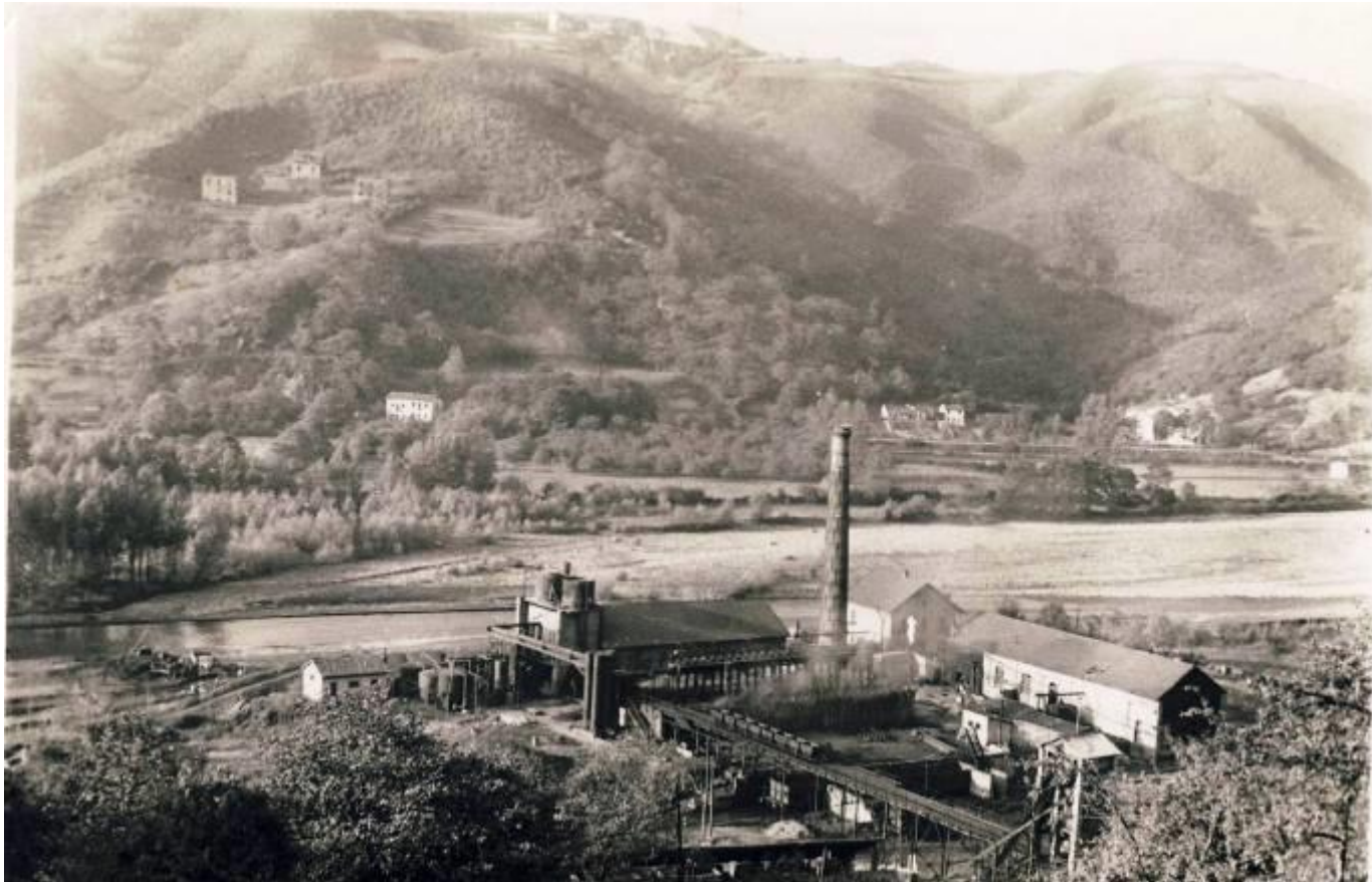
Ilustración 46. Instalación de los hornos de coque en La Pereda.
