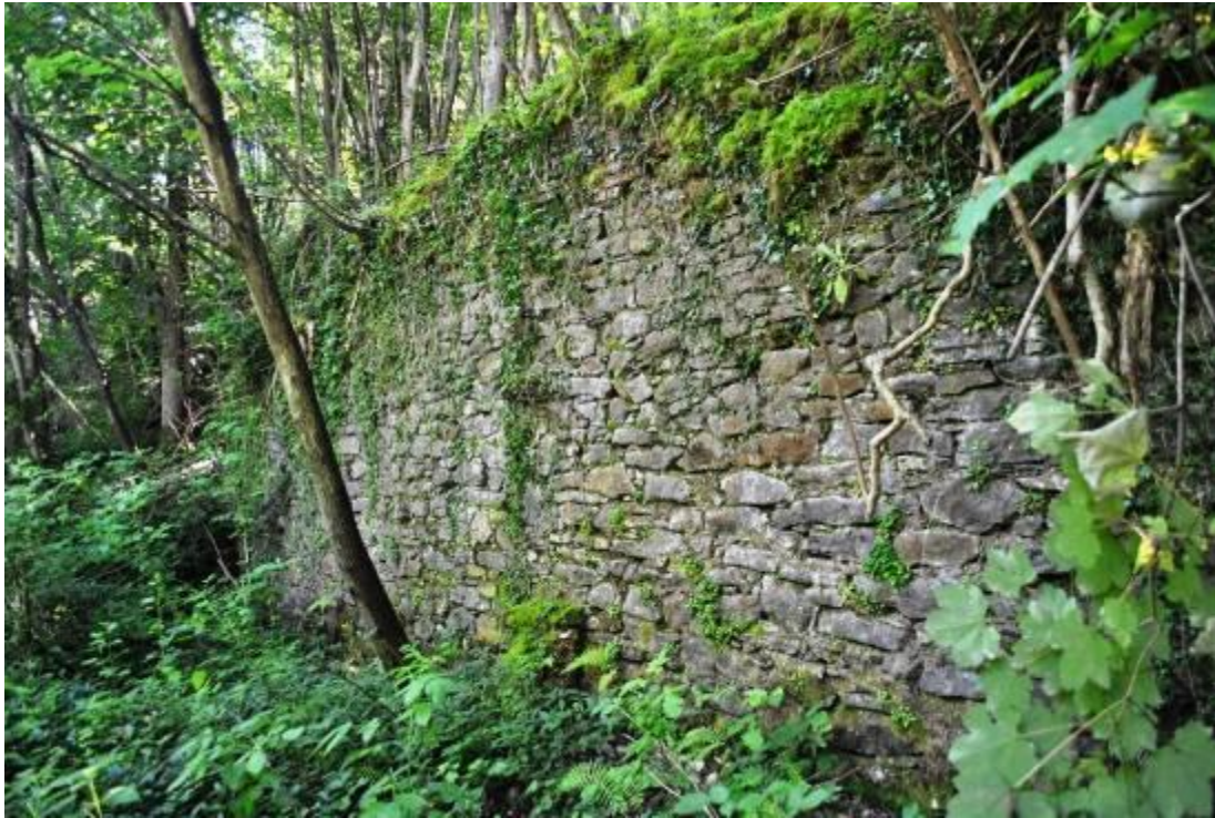
Ilustración 17. Restos actuales de la casa de máquinas en Reguera Grande. Fotografía de la Asociación Cultural Los Averinos.
