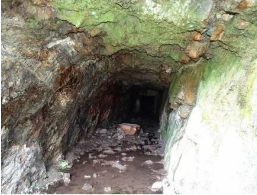
Ilustración 30. Grupo Canales. Bocamina del nivel 265, capa n° 8, piso 4°. Fotografía cortesía de José Luis Cabo Sariego.
