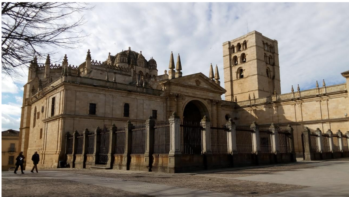
Fig. 1. Fachada norte y claustro de la catedral de Zamora. Fotografía del autor.
