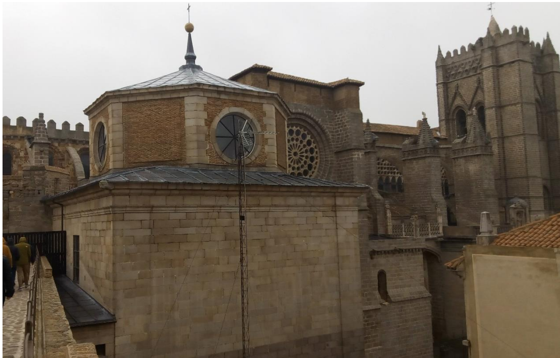
Fig. 16. Capilla de los Velada de la catedral de Ávila. Fotografía del autor tomada desde la muralla.
