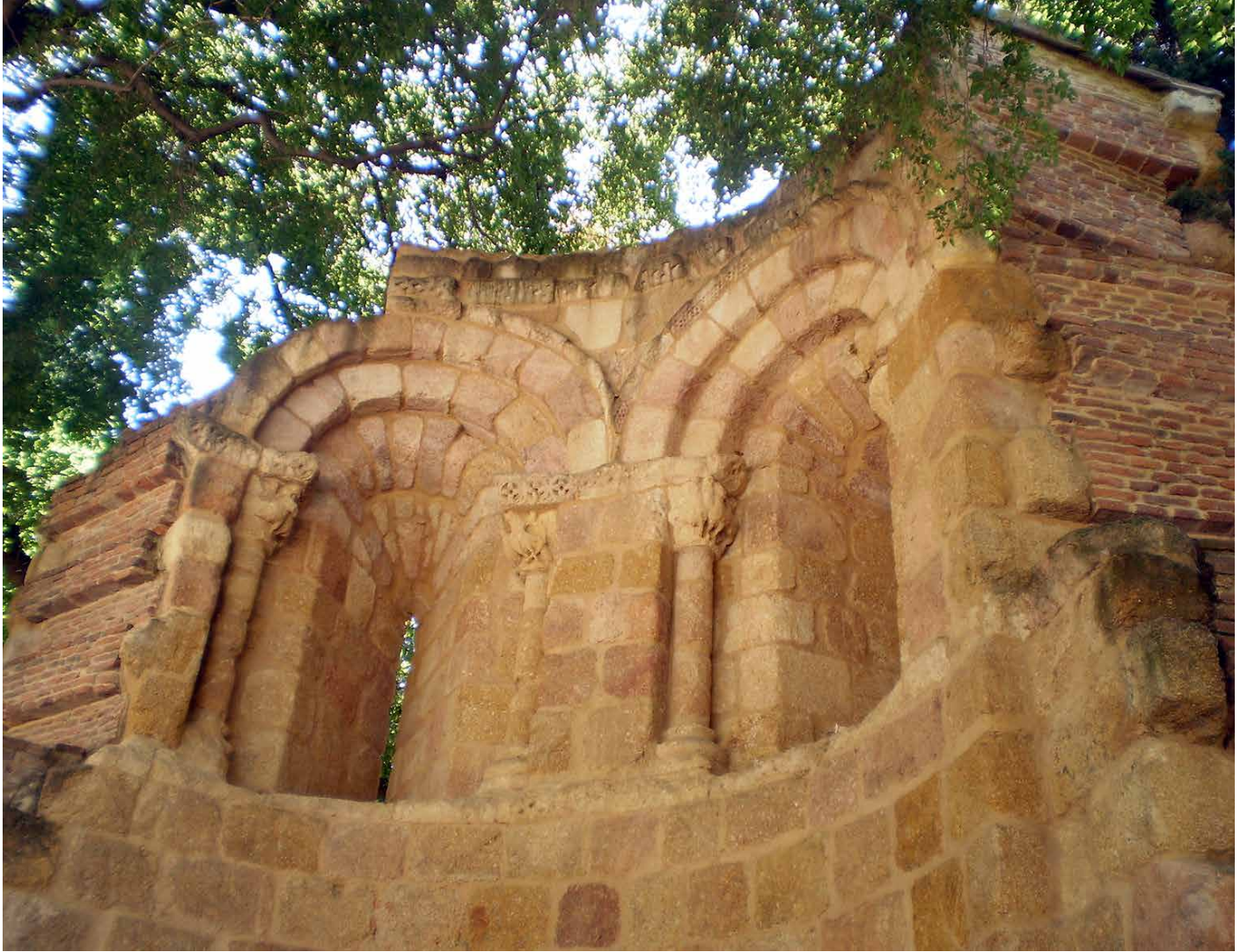
Fig. 3. Ermita de San Isidro en el Retiro. Ábside
