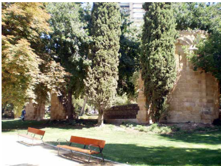
Fig. 1. Ermita de San Isidro en el Retiro. Vista general
