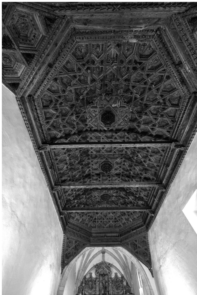
Armadura de cubierta. Nave de la Iglesia de la Asunción. Grijalba de Vidriales (fotografía: Miguel Ángel Fuertes Manjón).
