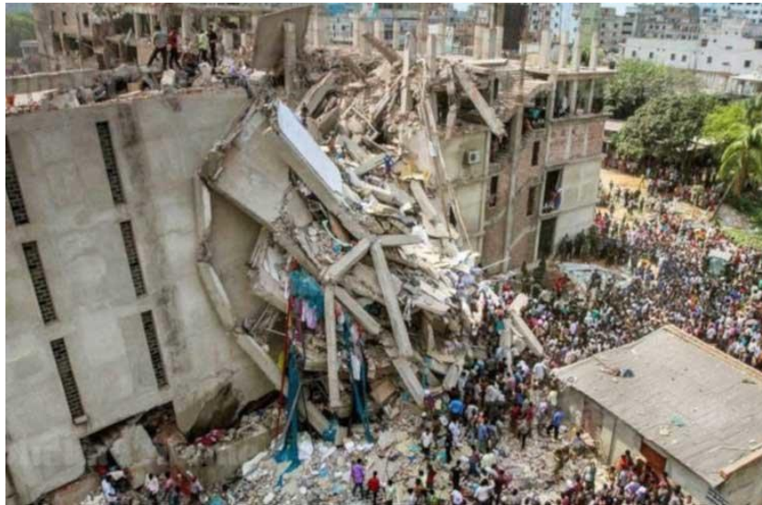
Figura 3.2 Derrumbe de la fábrica "Rana Plaza", Bangladesh, 2013.
