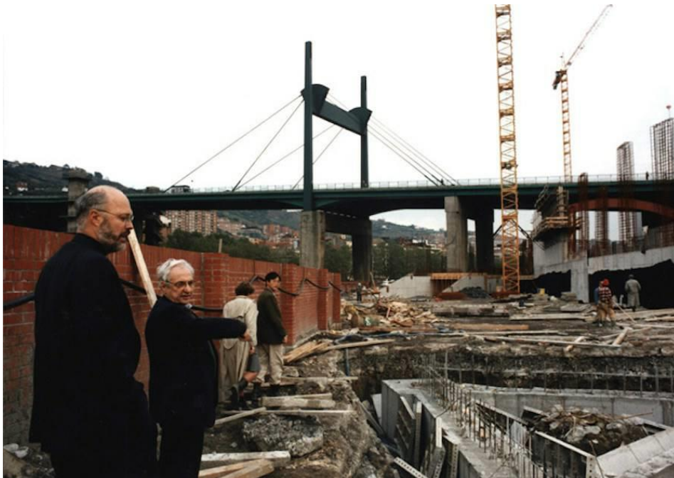
Figura A3.1.- Cimientos del Guggenheim en construcción con el puente de la Salve de fondo
