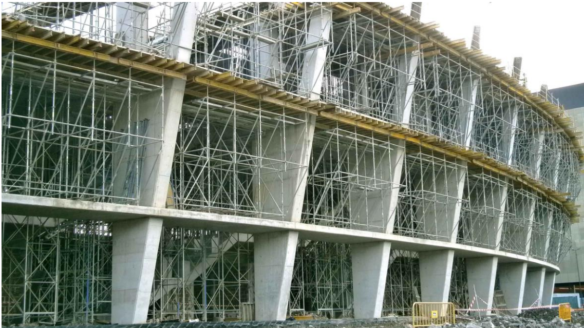
Figura A3.12.- Fachada del Estadio San Mamés en construcción
