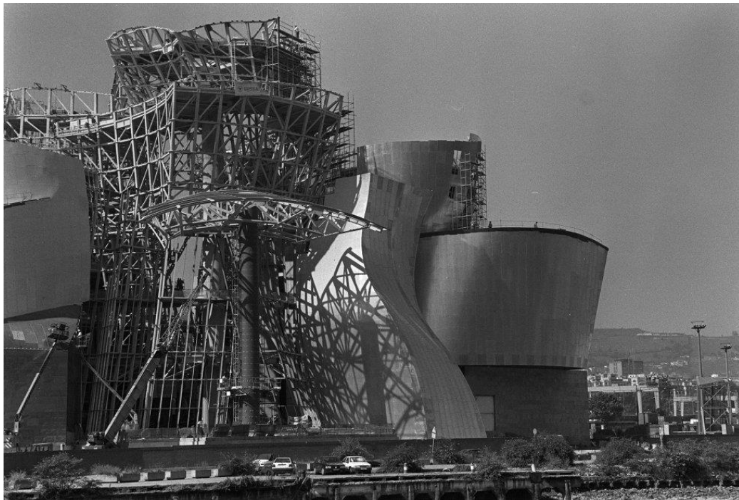
Figura A3.5.- Guggenheim en construcción
