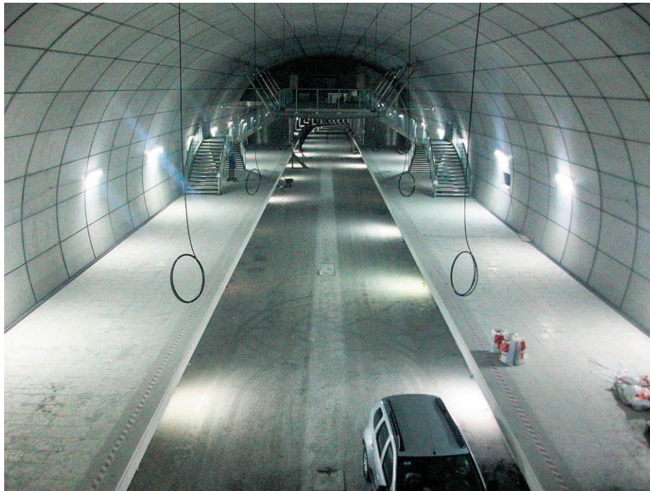
Figura A3.14.- Metro de Bilbao en construcción
