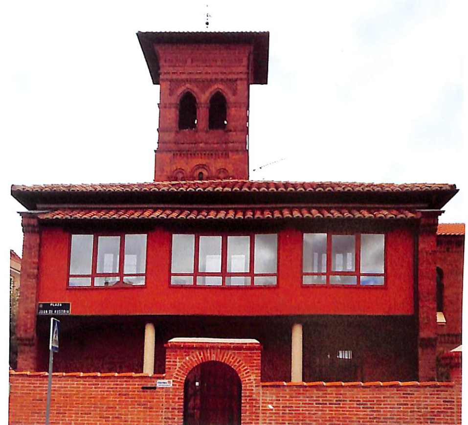
Sede de Cáritas Agrupación Parroquial "San José", institución con la que se colaboró para la realización del proyecto
