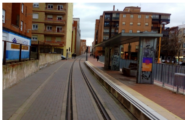
Figura 2. Línea de tren tram, sin utilizar, en León. Fuente: Foto del autor (2022).
