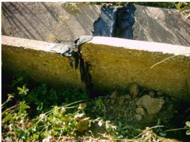
Detalle del ensamblado de dos canales
