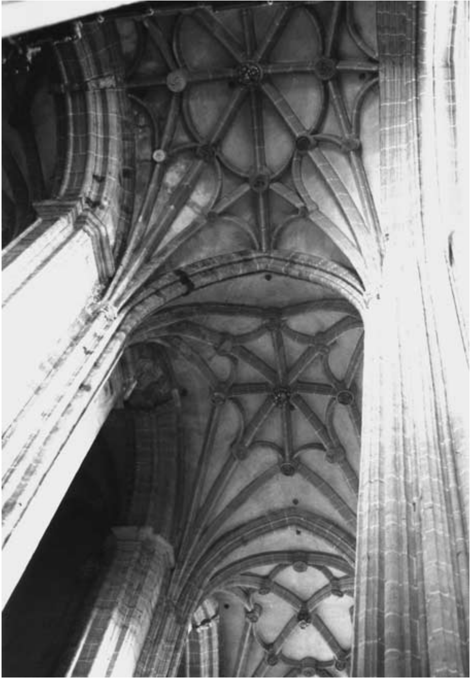
Fig. 7. Bóvedas de la nave lateral de la epístola de la catedral de Astorga.
